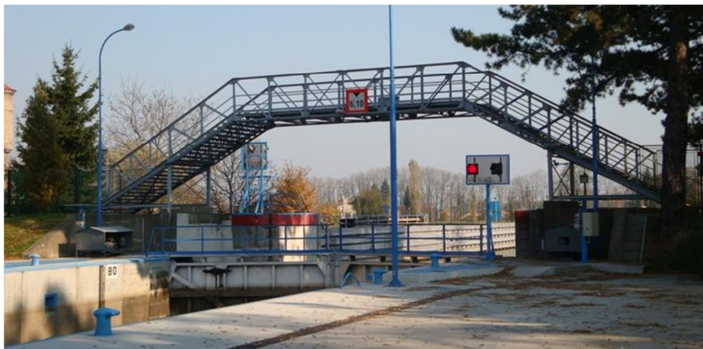
Obrázek 2.2: Stávající lávka přes plavební komoru Nymburk [Zdroj: http://www.labskastezka.cz/cz/galerie/fotogalerie/bariery/glr-264-nymburk-zdymadlo ]
