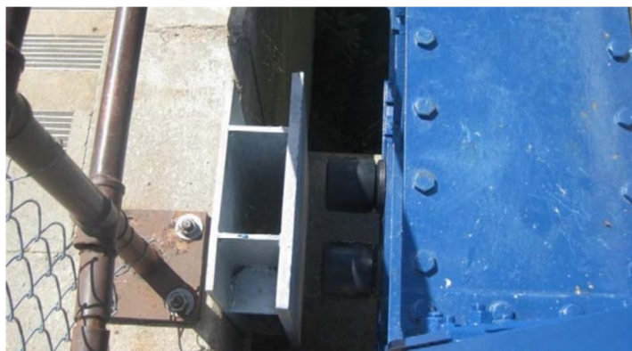
Obrázek 1.15: Schéma nastavitelných kloubových podpor [Zdroj: https://heavymovablestructures.org/wp-content/uploads/2017/12/282012KHM-HMS-Paper2.pdf ]
