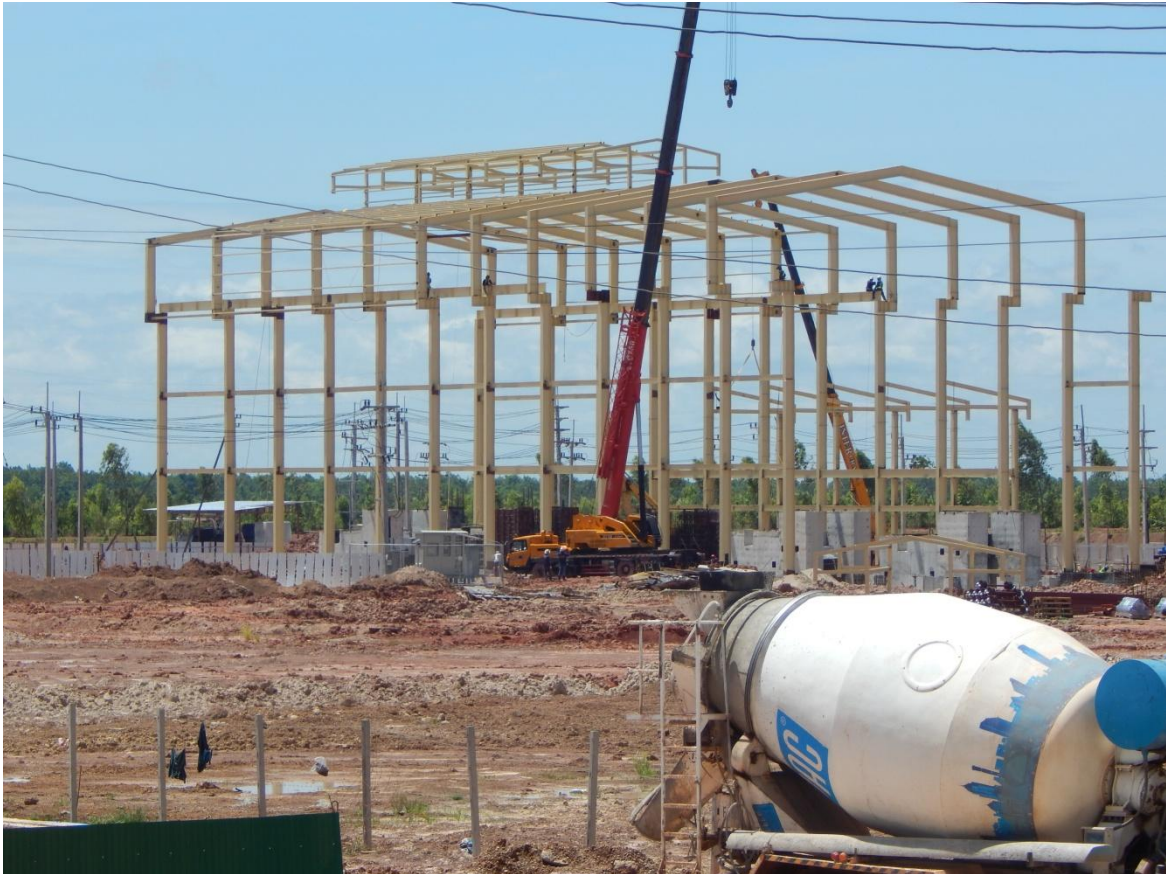
Obrázek 18 - První ocelová hala v provincii Sakon Nakhon (Zdroj: autor)
