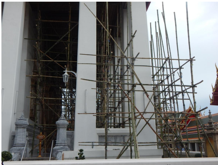
Obrázek 31 - Bambusové lešení v chrámu Wat Pho v Bangkoku (Zdroj: autor)
