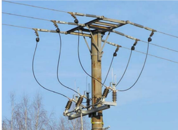
Obr. č. 2.8 - Bezkomorový úsekový odpínač Fle GB – podkošové provedení osazené četou PPN VN
