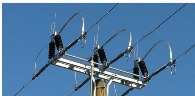
Obr. č. 2.7 - Bezkomorový úsekový odpínač Flc – základní provedení
