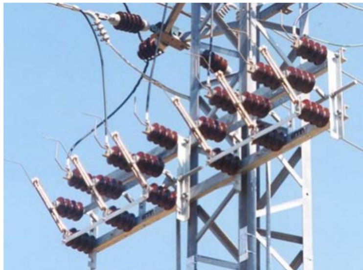
Obr. č. 2.9 - Dvojice svislých bezkomorových úsekových odpínačů R6400 25
