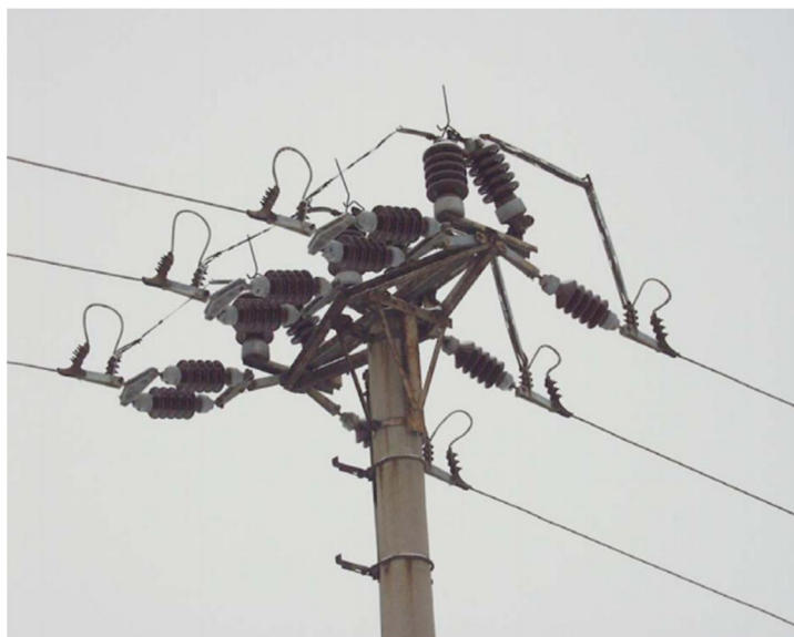
Obr. č.2.3 - Bezkomorový úsekový odpínač USV25
