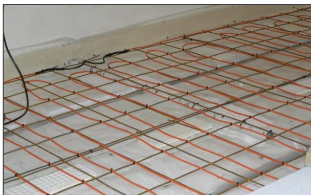
Obrázek 3 Uložení podlahového vytápění [11]
