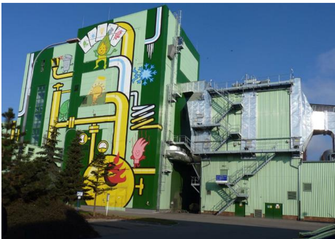
Obr. 13 – zelený blok teplárny
