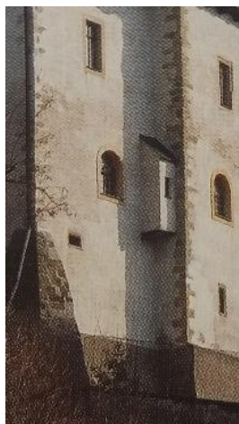
Obr. 32. Palác s vystupujícím prevétem v Mladé Boleslavi – převzato z (Razím, 2018).
