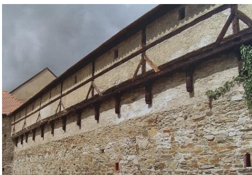
Obr. 22. Dochovaná hrázděná stěna ochozu v Českém Krumlově – převzato z (Razím, 2018).
