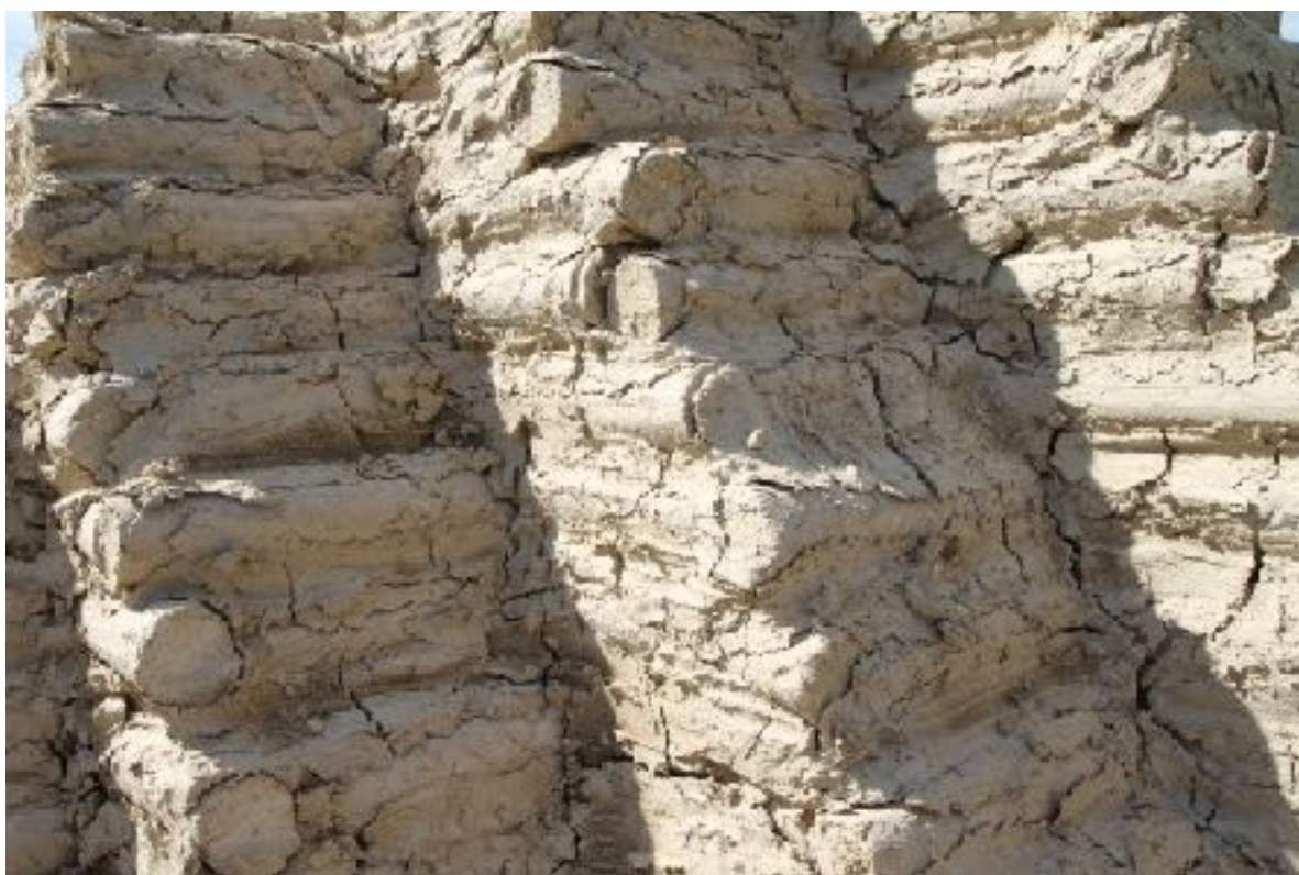
Fotka č.24 - Detail zatienenej časti objektu, den po dokončení
