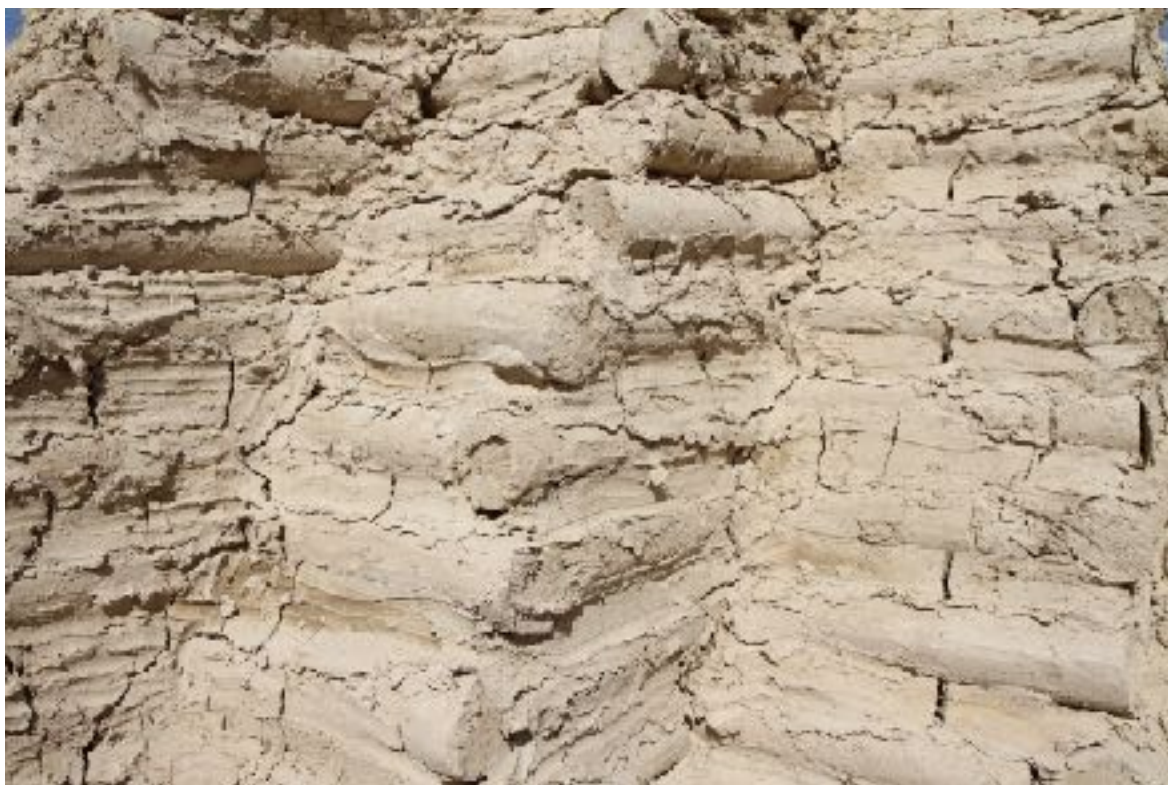
Fotka č.23 - detail objektu počas priameho slnka, den po dokončení
