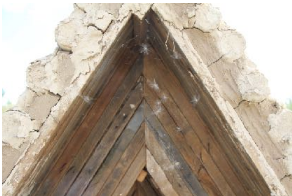
Fotka č.22 - dom pavúka v objekte, den po dokončení stavby
