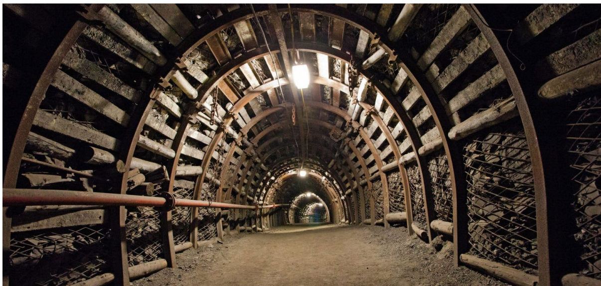
Obrázek 21, příklad osvětlení v důlní šachtě
