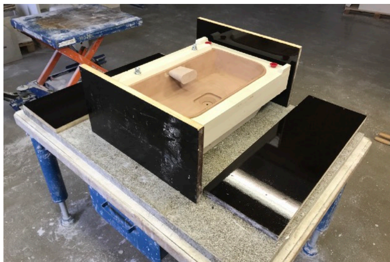
Příprava desek na tvorbu bednění
