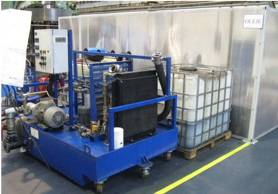
Obr.6-1.2 Uložení olejů v prostoru montáže
