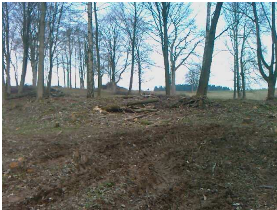
Obr. 27: Destrukce – pohled od hráze.
