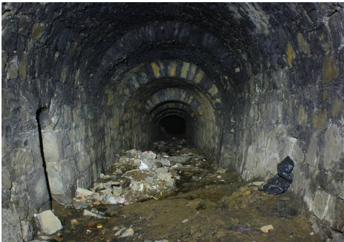
Obr. 43: Interiér propustku. Vlevo je zřetelné vyústění štoly.
