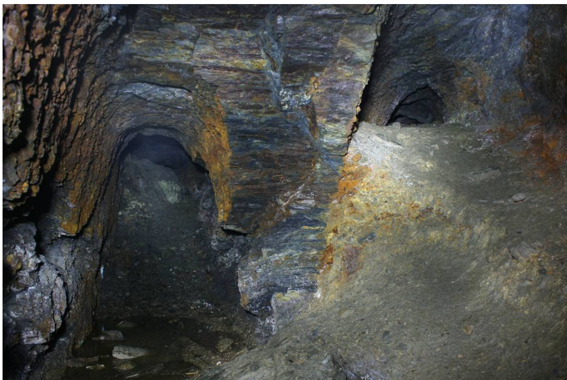
Obr. 44: Interiér jižní štoly v propustku
