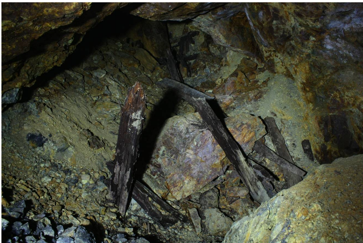
Obr. 37: Zával se zbytky výdřevy v Hlavní štolě
