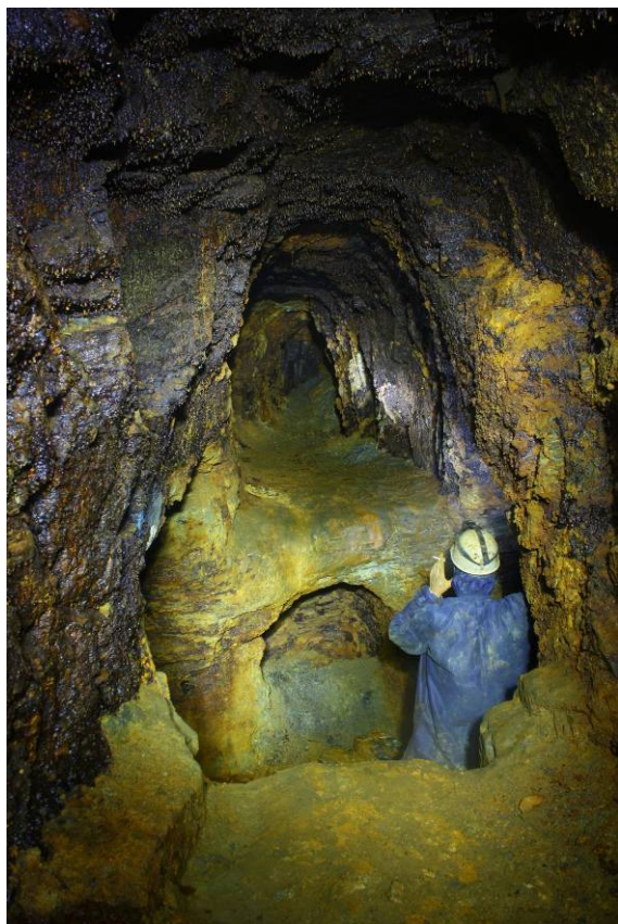
Obr. 31: Mimoúrovňové křížení tří chodeb
