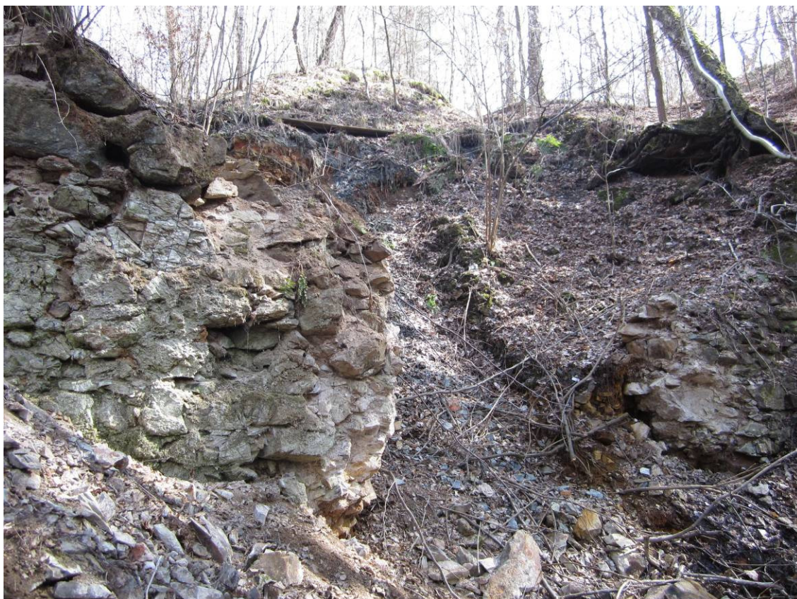
Obr. 21: Zavalené dolní ústí vodního tunelu
