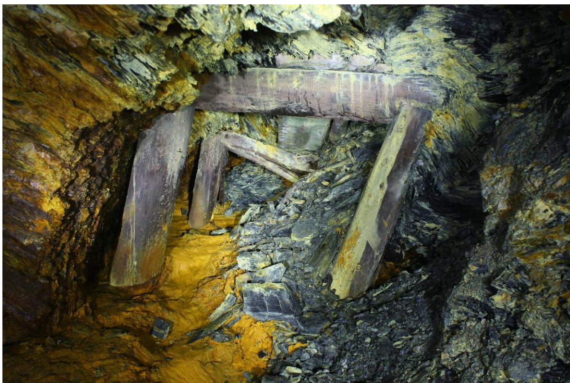
Obr. 25: Výdřeva v podzemním systému
