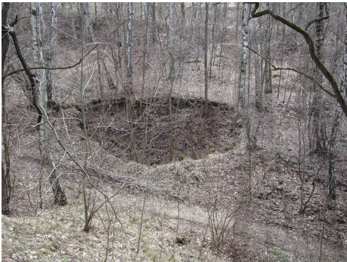
Obr. 22: Propad do vodního tunelu
