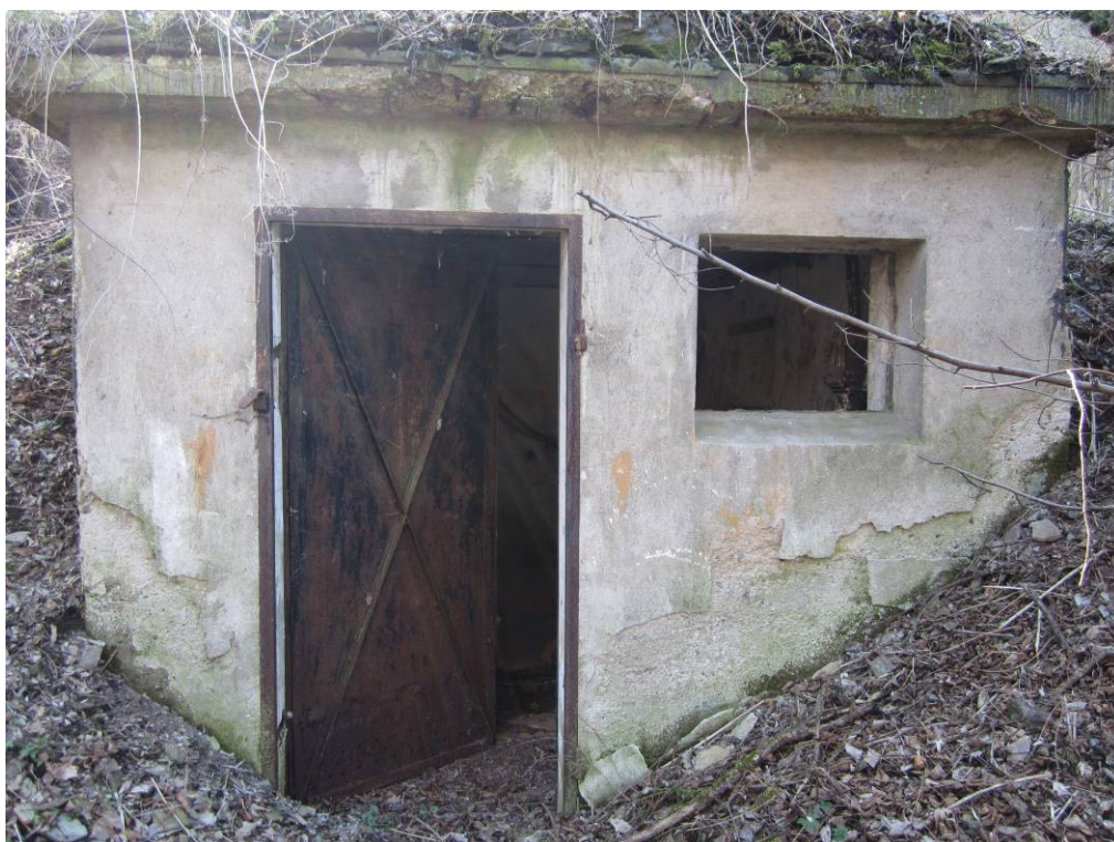
Obr. 40: Stavba pro čerpací zařízení
