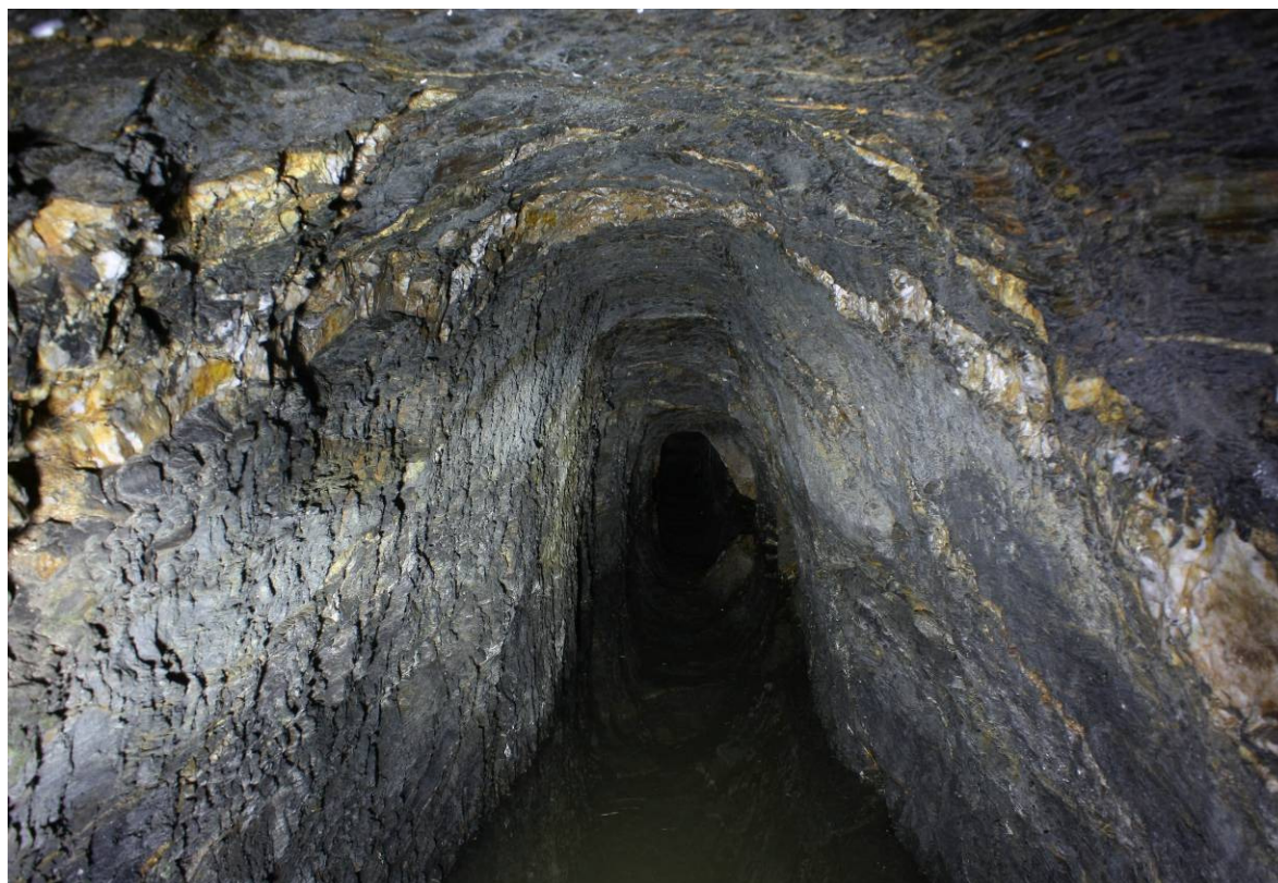
Obr. 48: Interiér severní štoly nad řekou Klabavou
