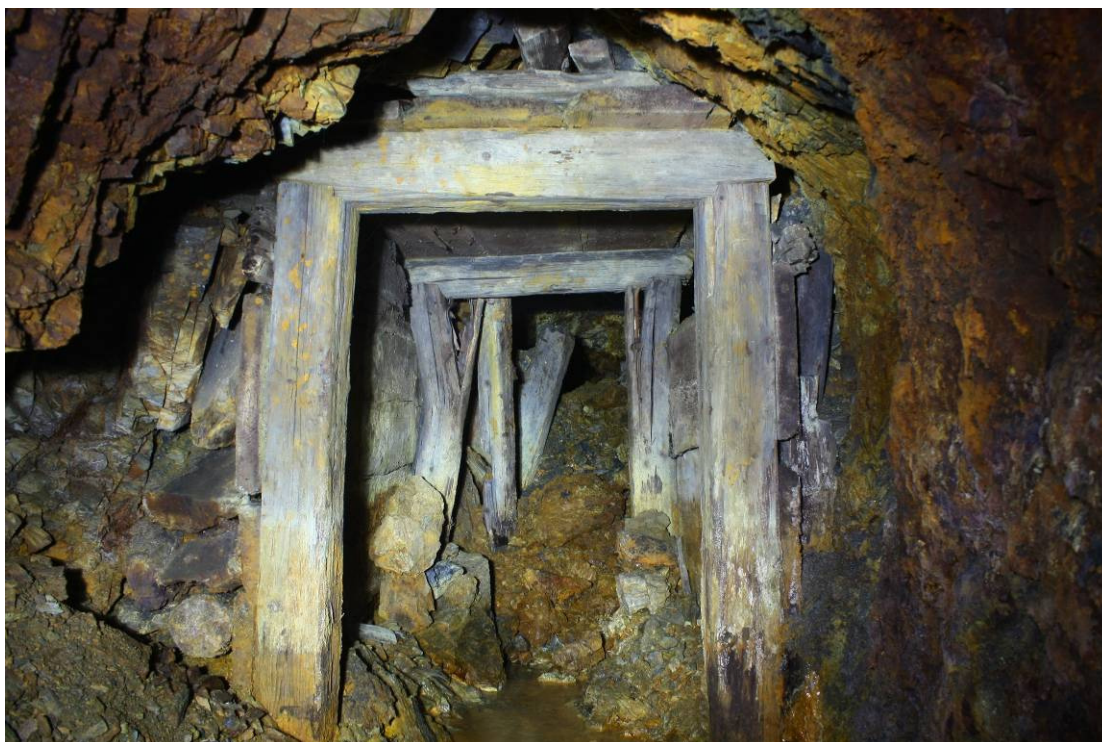
Obr. 18: Vydřeva v dolní štole
