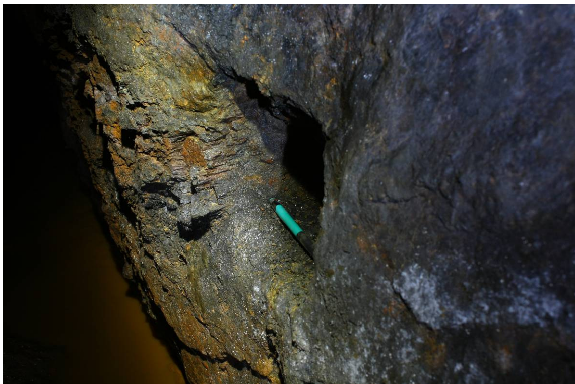
Obr. 45: Výklenek pravděpodobně pro umístění svítidla (měřítko propiska). Jižní štola v propustku.
