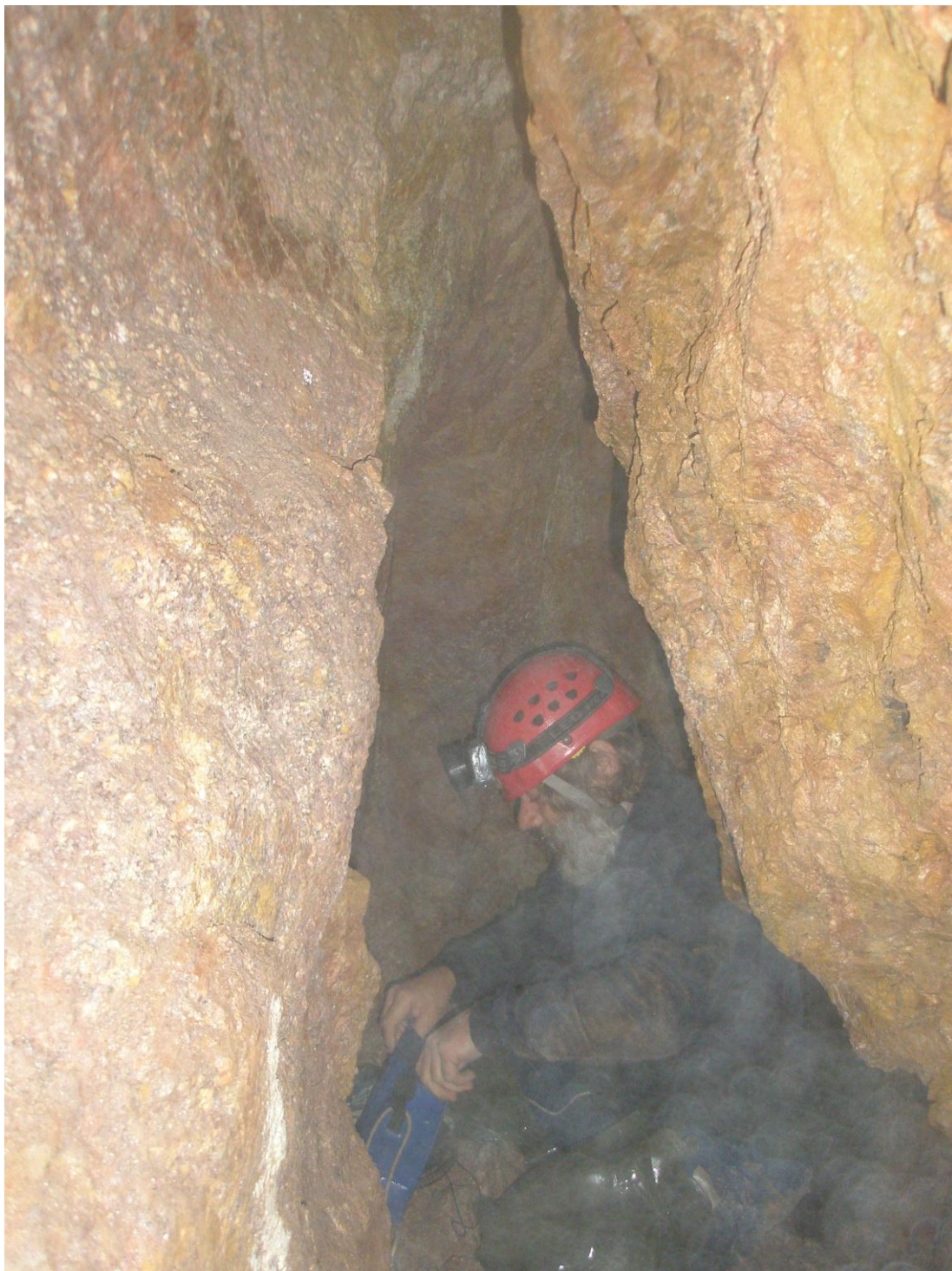
Obr. č. 20: Stropní dobývka ve št. faráře Plössela, narušující konstantní profil štoly (foto autor)
