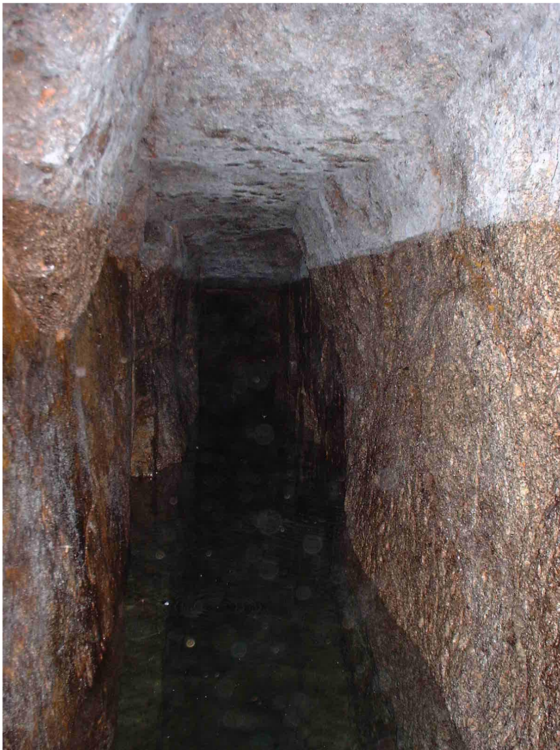
Obr. 19: Št. faráře Plössela – na stropě patrná původní hranice vody před odkrytím, u počvy patrný odtokový kanálek zaražený do masivu (foto P. Bouše 2002)
