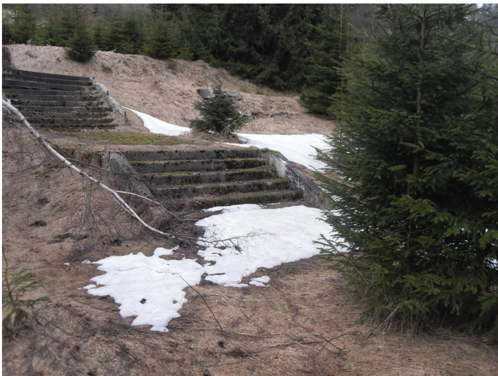
Obr. 11.17 Betonové schodiště na lokalitě tábora Vršek
