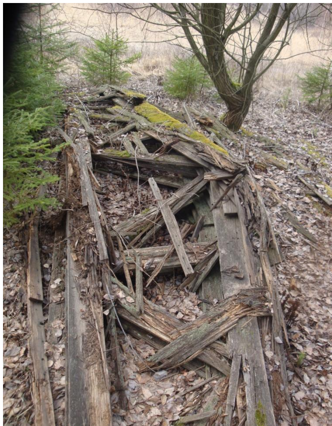
Obr. 11.11 Dřevěná konstrukce na lokalitě tábora Vojna
