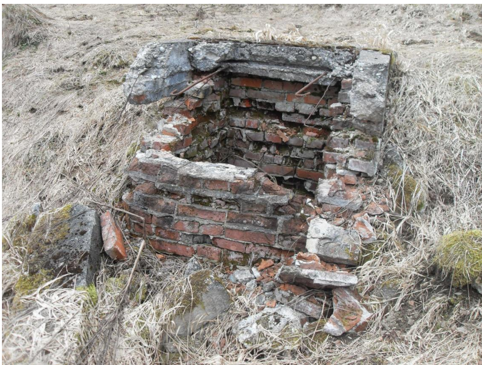
Obr. 11.16 Kanalizační vpust' na lokalitě tábora Vršek
