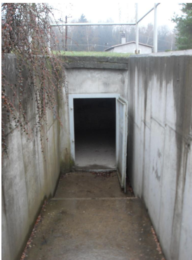
Obr. 11.8 Betonový bunkr na lokalitě tábora Vojna
