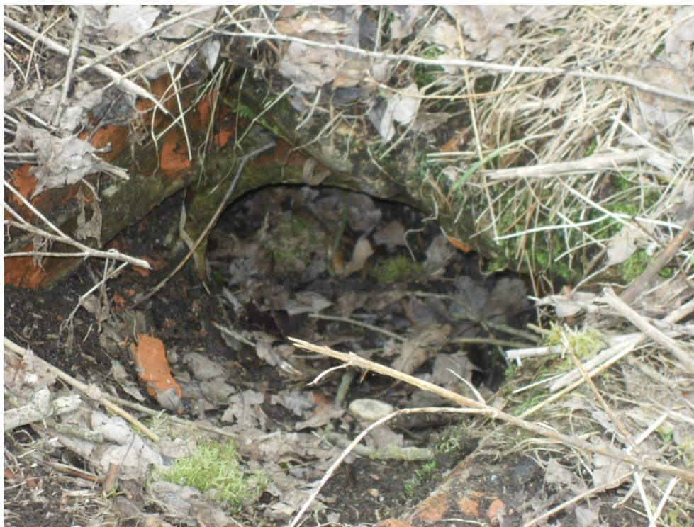
Obr. 11.13 Kanalizační vpust' na lokalitě tábora Nikolaj
