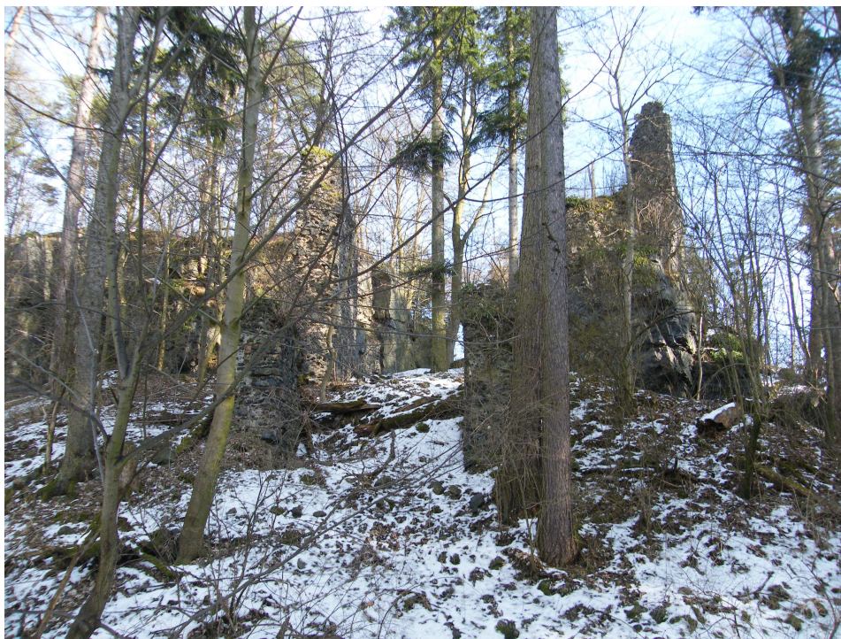
Obr. 29 Pohled na horní hrad od severovýchodu, v popředí branská věž. Foto autor
