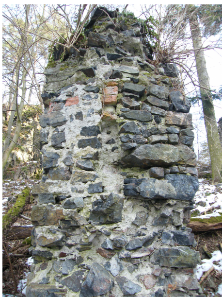
Obr. 30 Pohled na cihelné ostění střílny branské věže. Foto autor
