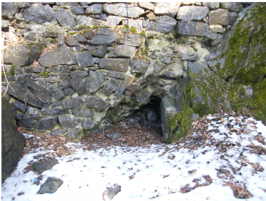
Obr. 34 Opravované a narušené zdivo pod portálem brány dolního hradu. Foto autor
