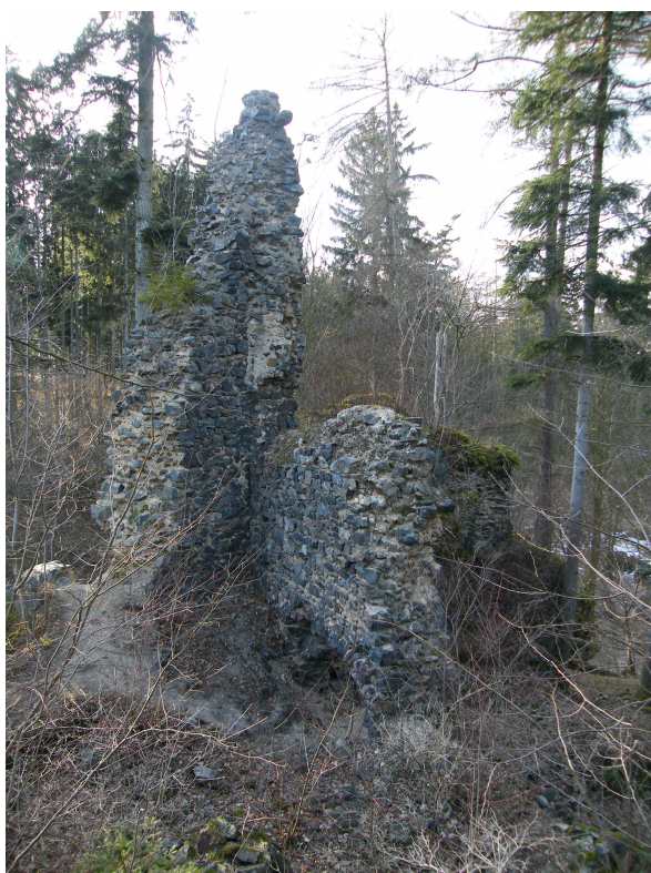
Obr. 23 Interiér budovy stojící nad branskou věží. Foto autor
