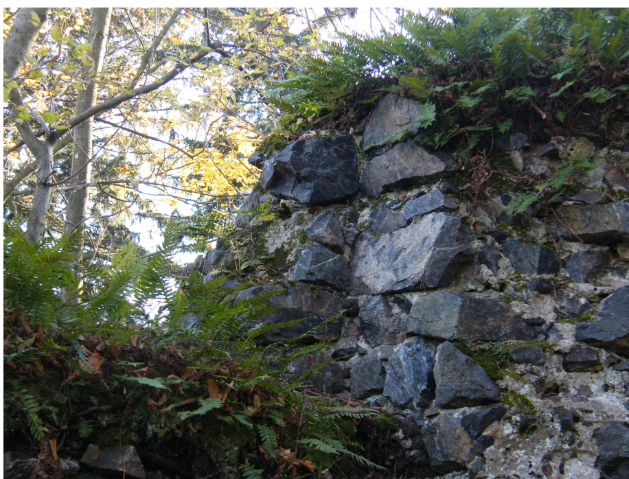
Obr. 37 Dochovaná špaleta okna paláce dolního hradu. Foto autor
