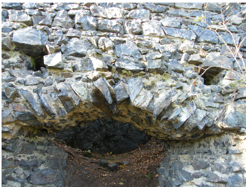
Obr. 44 Pohled na portál horního hradu. Foto autor
