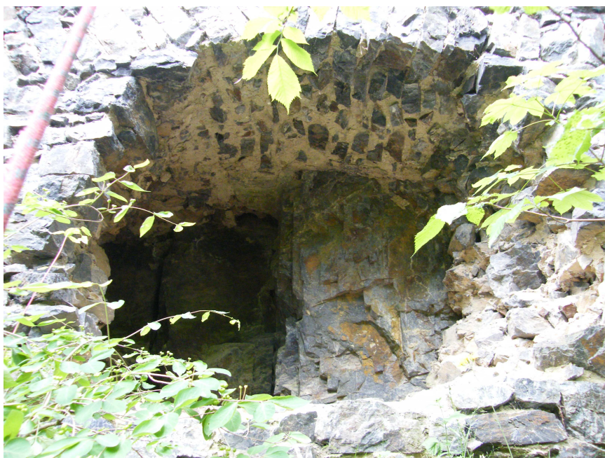
Obr. 31 pohled do výklenku vylehčovacího pasu v severní zdi jádra horního hradu. Foto Ondřej Bouše
