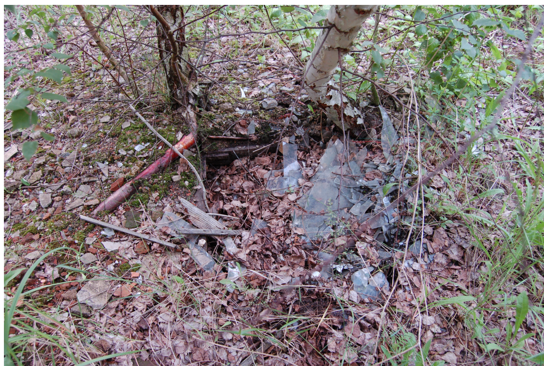
Příloha 39 – Objekt č.5
