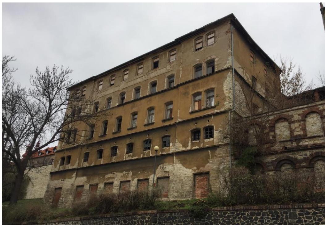
Obrázek 7. Prázdná budova v rekonstrukci, náměstí svobody 1884, Hotel Hanslík, pohled z Nákladní ulice
