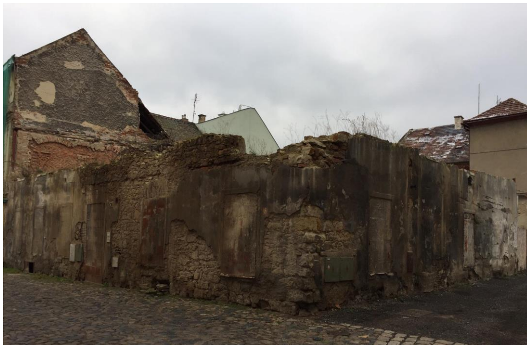
Obrázek 9. Prázdná budova, J. Hory 93
