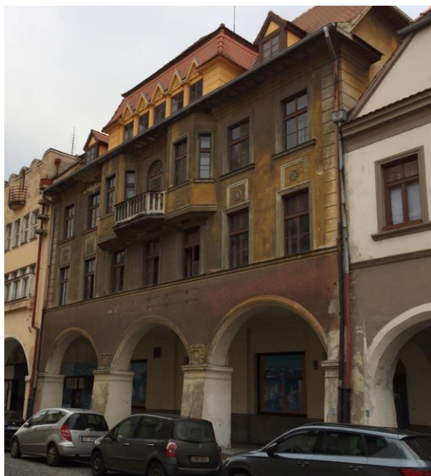
Obrázek 8. Prázdná budova v rekonstrukci, náměstí svobody 59, Hotel Hanslík
