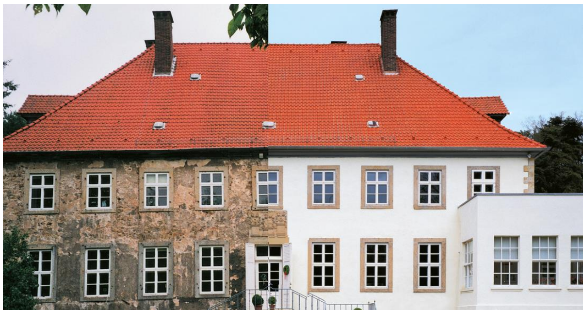
Obrázek 6-1. Oprava památkově chráněného domu v německém Kitzingenu.
