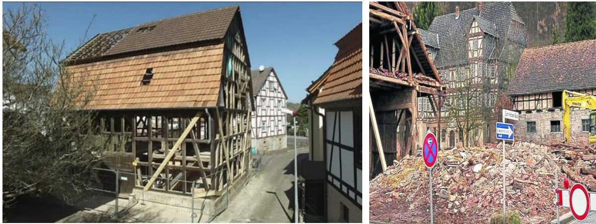
Obrázek 16-8. Wanfried. Sanace hrázděných domů.
