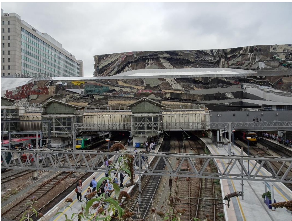
Obrázek 14-4. Hlavní nádraží Birmingham New Street: zrenovovaná „vstupní brána“ do města. Vnější plášť je tvořen lesklými kovovými pláty, které odráží objekty v okolí a opticky zvětšuje prostor.
