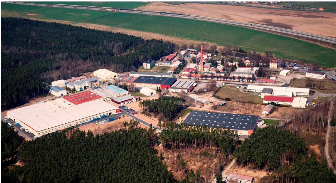
Obr. 5 : Letecký pohled na společnost DIOS NÝŘANY a.s.
