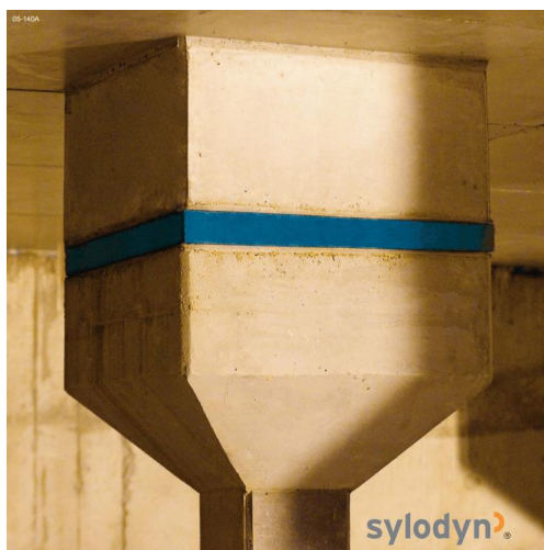
Obrázek 29: Uložení vibroizolační desky Sylodyn HRB-HS na hlavici sloupu; (28)
