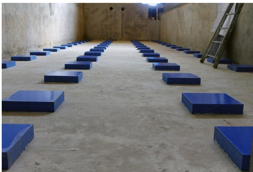
Obrázek 28: Bodově umístěná vibroizolace z pružných desek (Sylodyn); (27)
