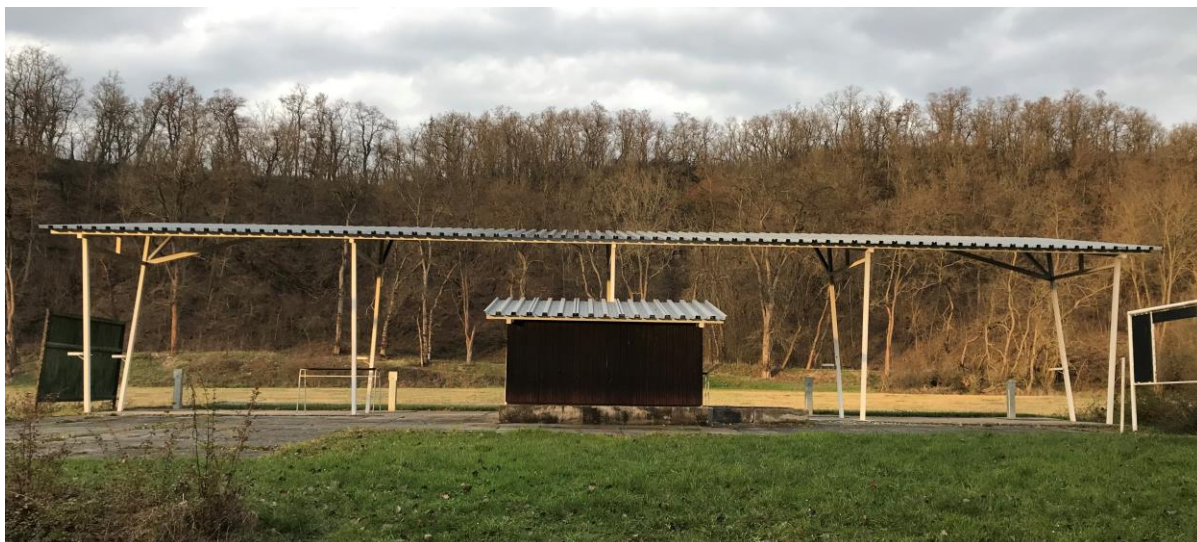
Obrázek 24: Střelecký přístřešek – ocelová konstrukce [Autor]
