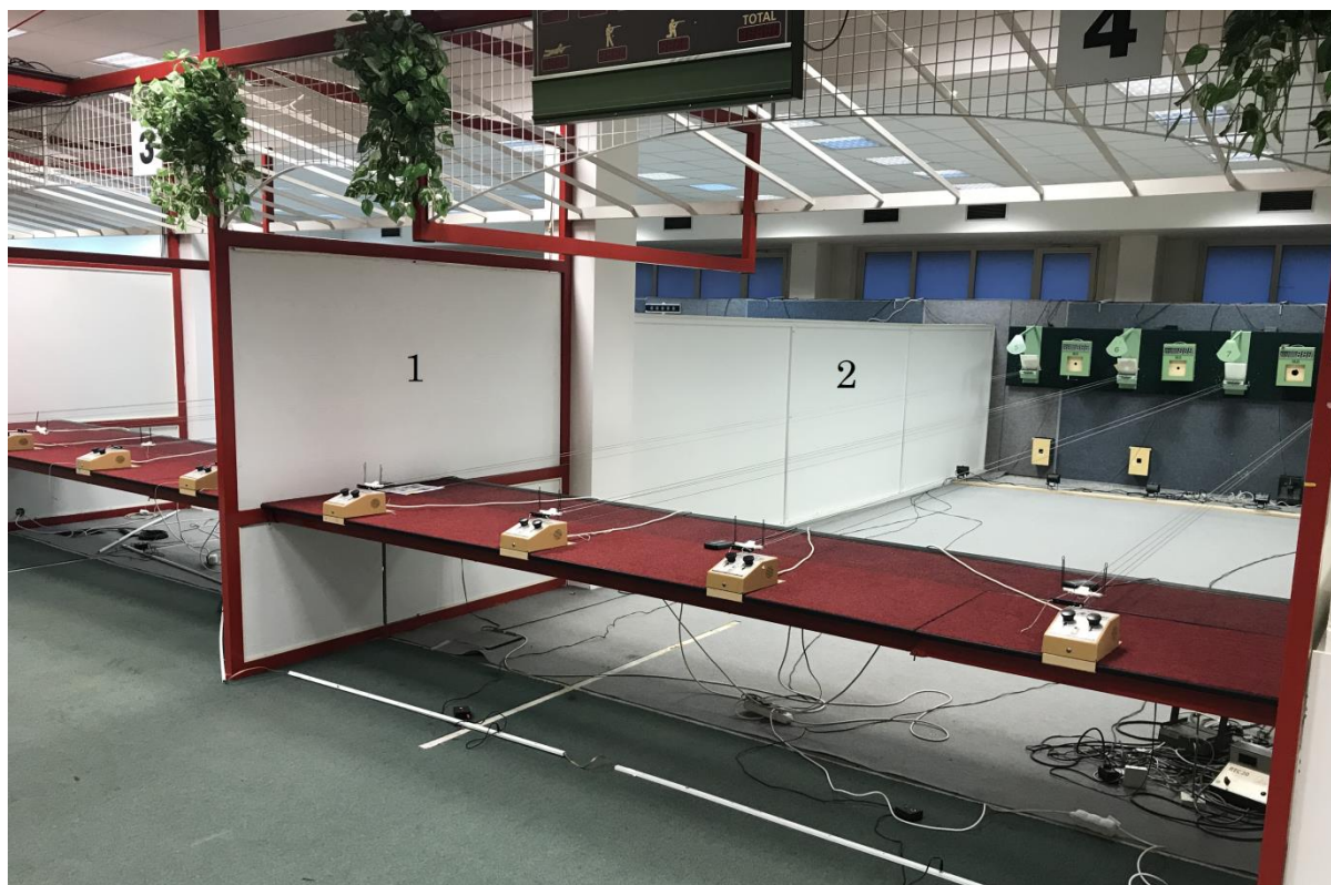
Obrázek 10: Ochranná stěna a zástěna [Autor]
