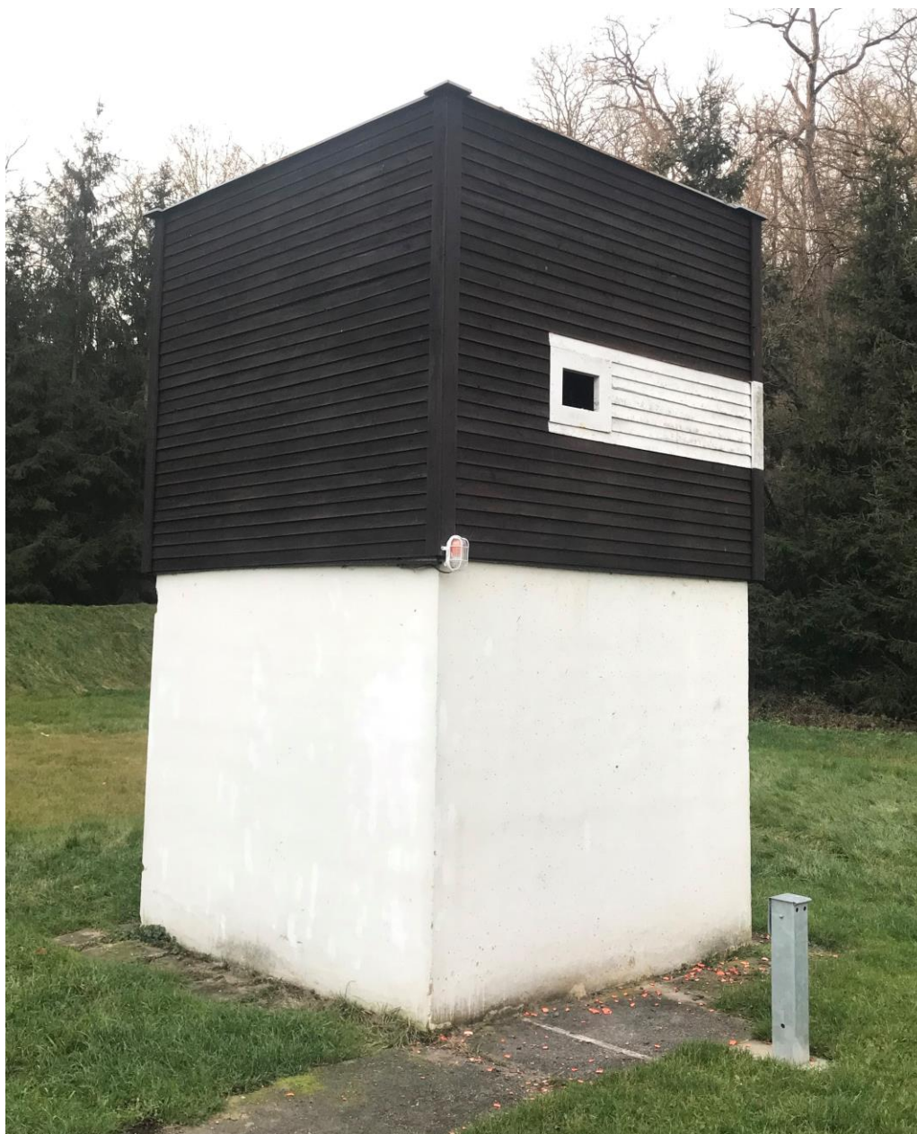
Obrázek 23: Vysoká věž s ochranným štítkem a výstražným světlem [Autor]
