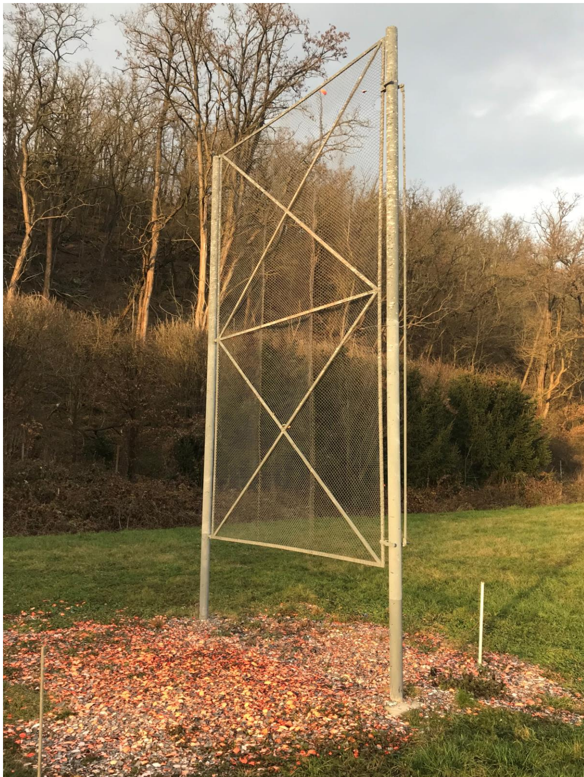
Obrázek 20: Venkovní ochranná stěna – ocelová konstrukce [Autor]
