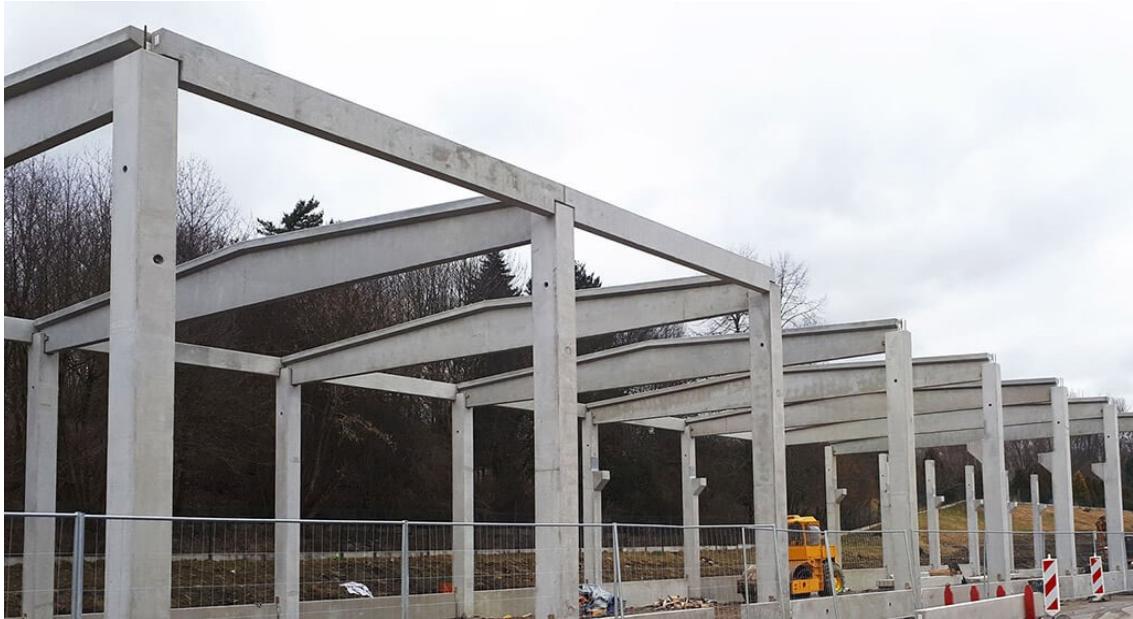
Obr. č. 32: Obrázek betonové konstrukce [26]
