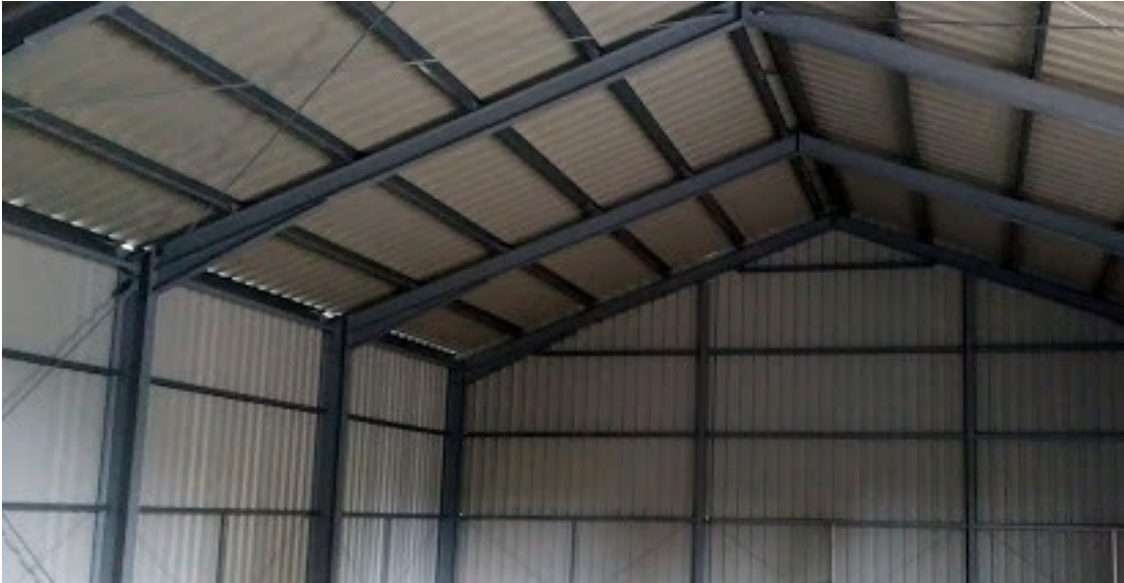
Obr. č. 18: Obrázek ocelové rámové konstrukce [19]
