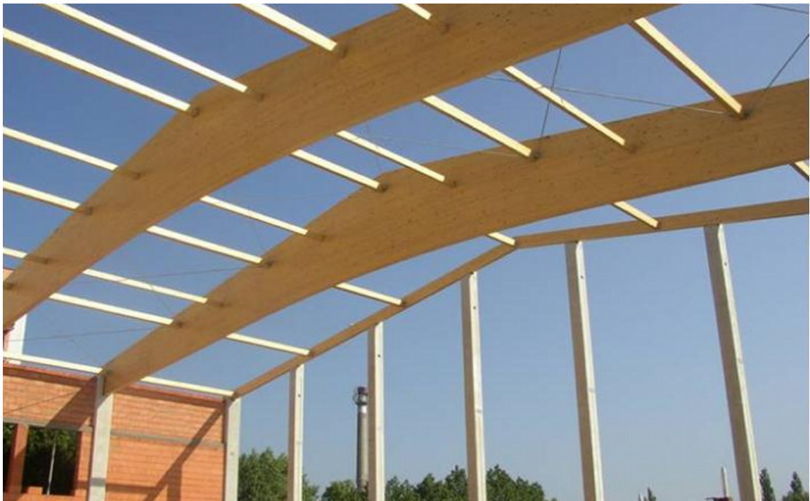
Obr. č. 26: Obrázek dřevěného plnostěnného vazníku [23]
