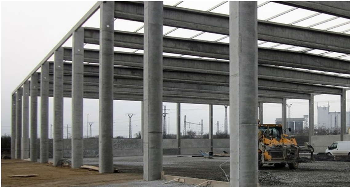
Obr. č. 30: Obrázek betonové konstrukce [25]
