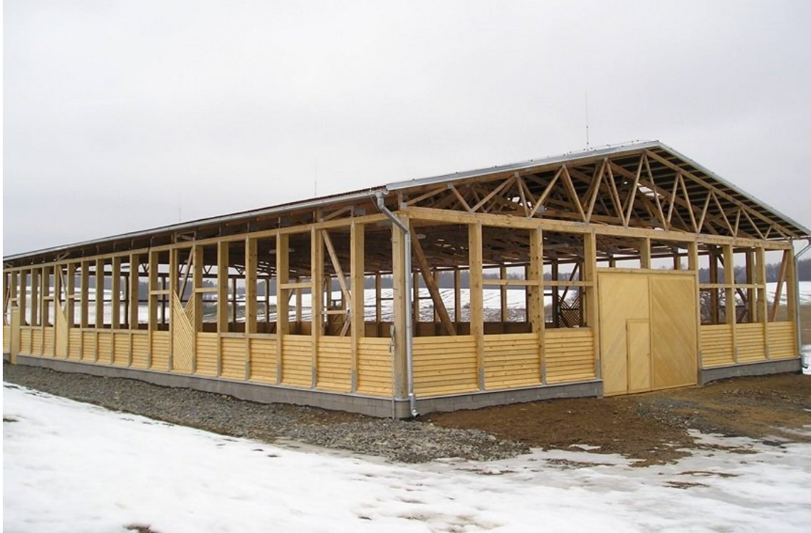
Obr. č. 28: Obrázek dřevěné příhradové konstrukce [24]
