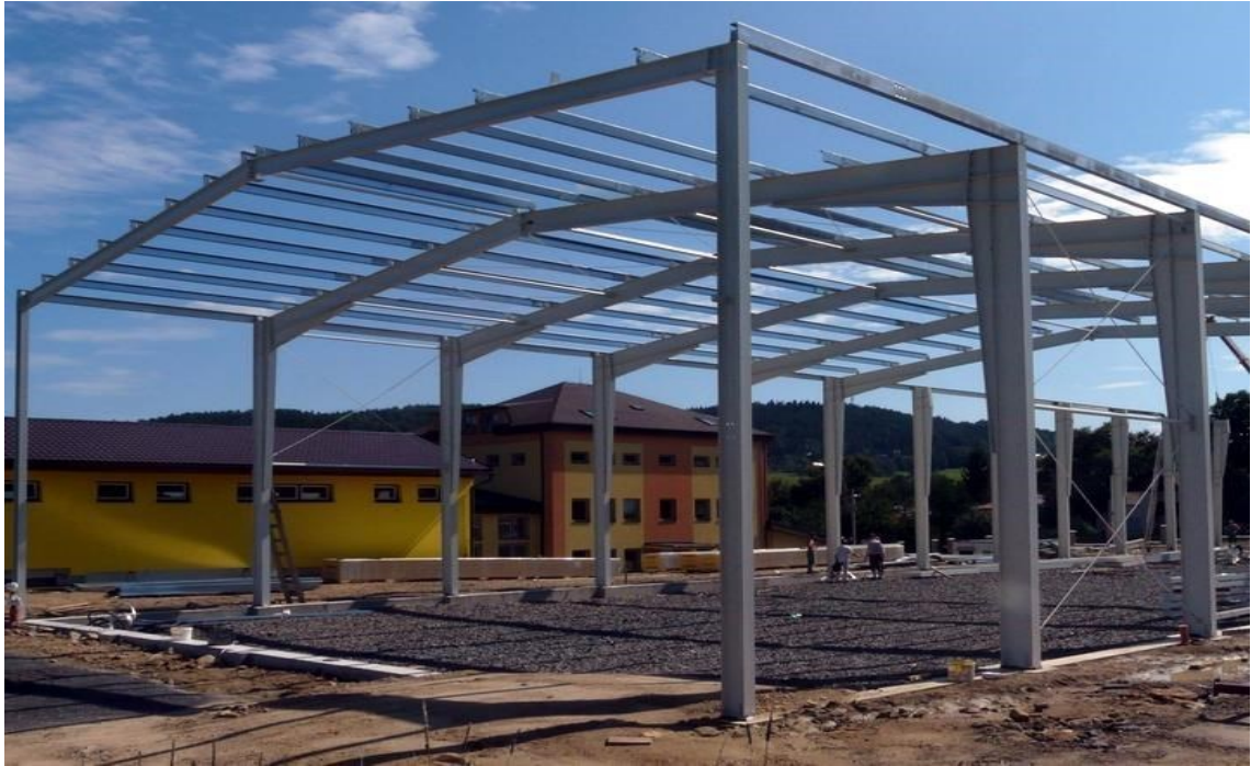
Obr. č. 24: Obrázek ocelové rámové konstrukce [22]
