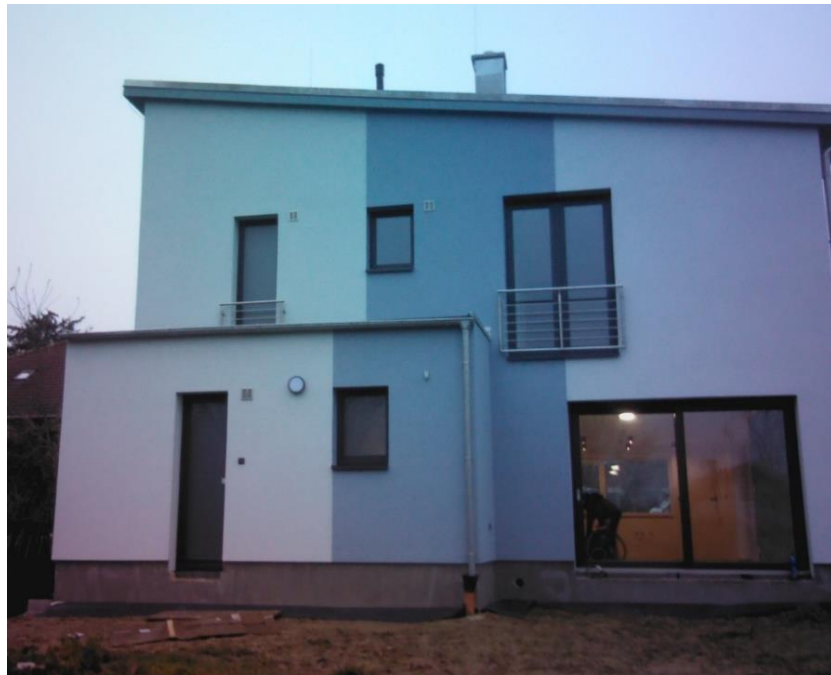
[37] - Pohled ze severní strany na objekt vyzdívaný ze systému Porotherm – digitální snímek
