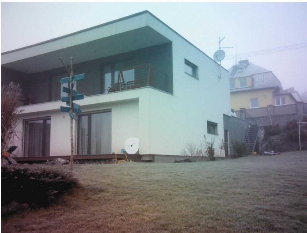
[22] Dřevostavba – Pohled na posuzovanou budovu – digitální fotografie
