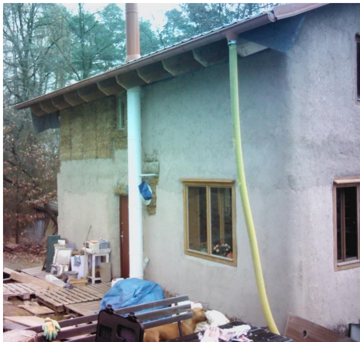
[27] - Pohled na slaměný dům na jak hotové, tak rozpracované části bez omítnutí – digitální snímek
