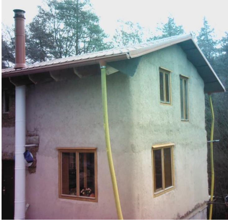
[28] - Pohled z jihozápadní strany na převážně dodělanou stranu, u přízemí je již vyhotovena jemnozrná omítka , ve 2. NP jemnozrná omítka stále chybí – digitální snímek
