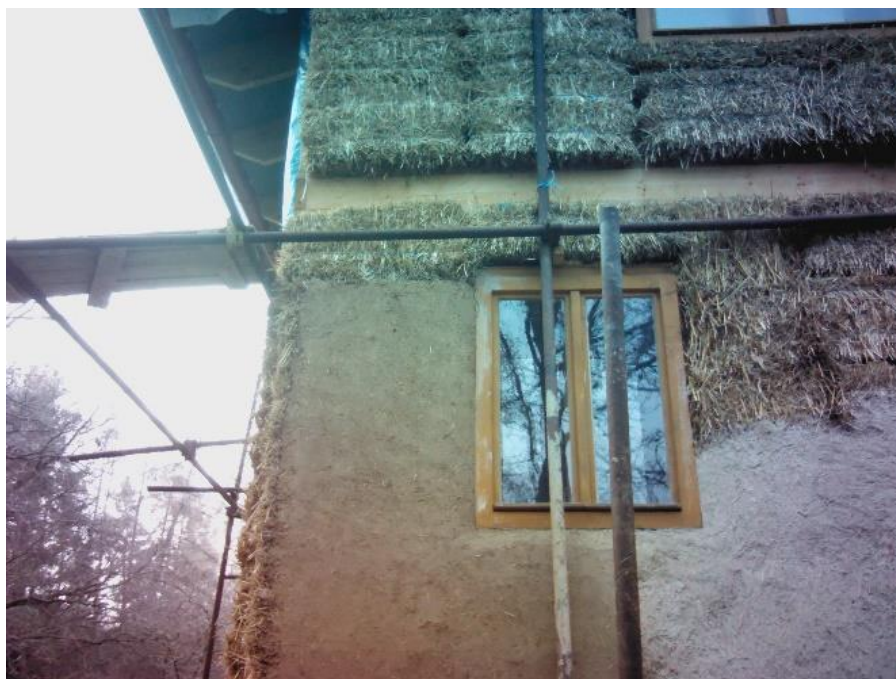
[33] - Přejechod mezi rozdělanými částmi, na levé straně nevyschlá omítka, na horní část neomítnutu, v dolním pravém rohu hrubozrnná omítka s řezankou – digitální snímek
