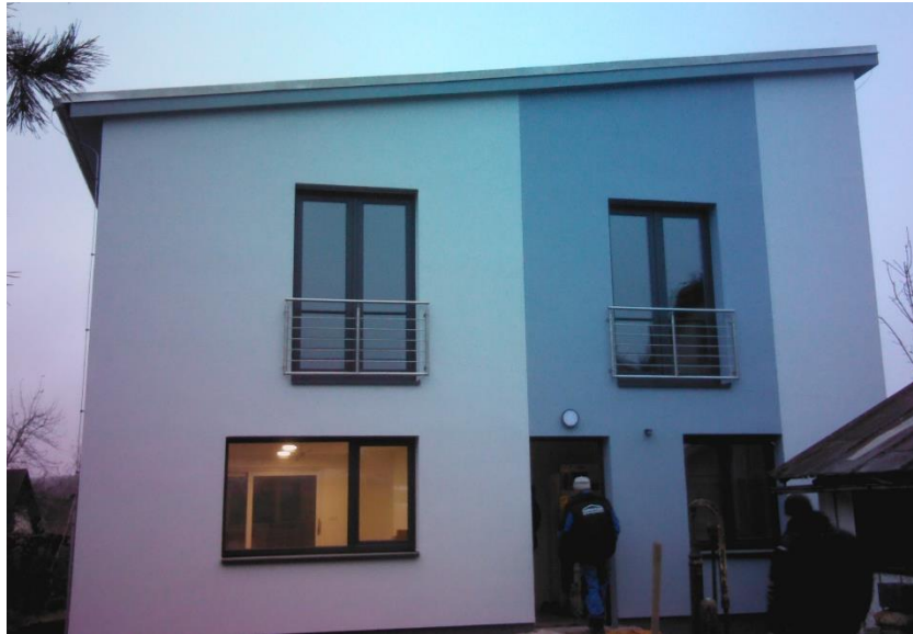
[36] - Pohled z jižní strany na objekt vyzdívaný ze systému Porotherm – digitální snímek
