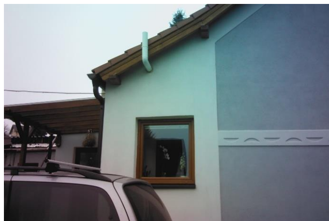
[48] - Rozdíl pálené (CPP, levá část) a nepálené cihly (pravá část) – digitální snímek
