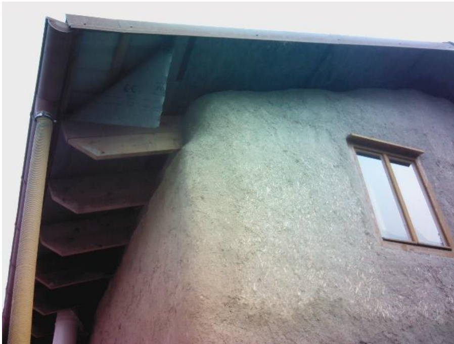
[35] - Pohled na dodělanou část hliněné omítky, přechod stěny a krovu – digitální snímek
