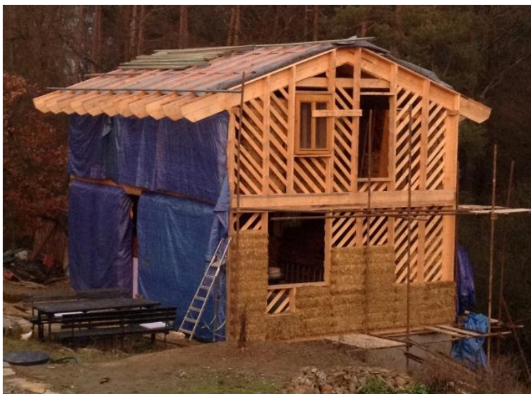
[2] Sláma jako výplňový materiál, zavětrování
