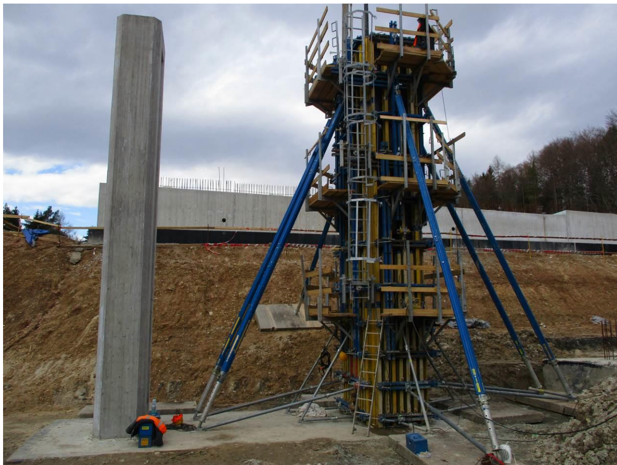
Obrázek 15 – Foto bednění pilíře (Česká Doka) mostního objektu a předchozího provedeného, již odbedněného mostního pilíře.
