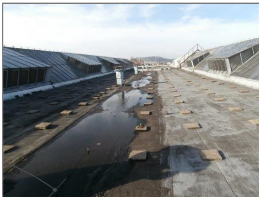
Obrázek 25: Problém stojící vody [23]
