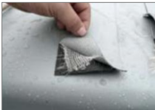
Obrázek 28: Delaminace fólie [21]
