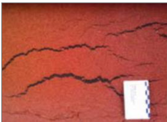
Obrázek 16: Sjíždění asfaltové hmoty [21]
