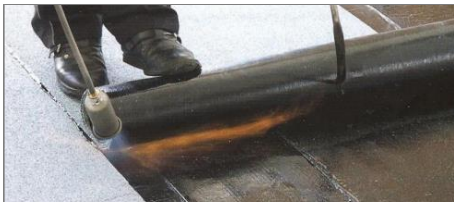
Obrázek 6: Natavení propan-butanovým hořákem [16]
