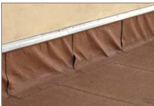
Obrázek 20: Vlnění hydroizolace a tzv. delaminace spojů [21]
