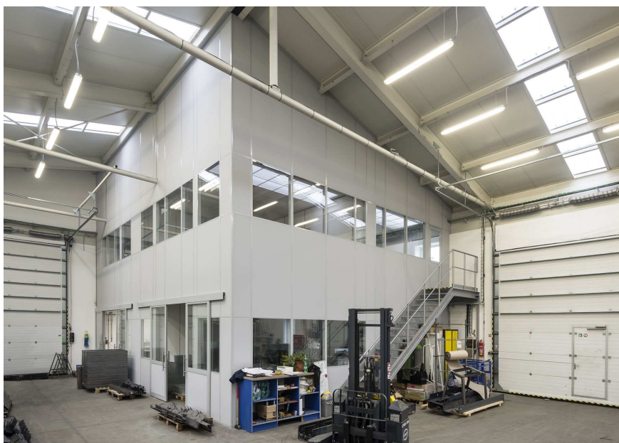
obr. /17/ Dodatečný vestavek v hale [14]
