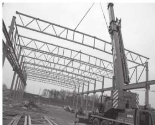
obr. /22/ Montáž PREON nosníku [2]
