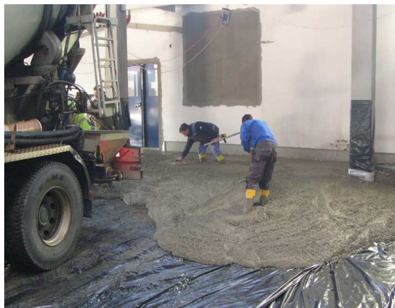
obr. /10/ Betonáž drátkobetonové podlahy [9]
