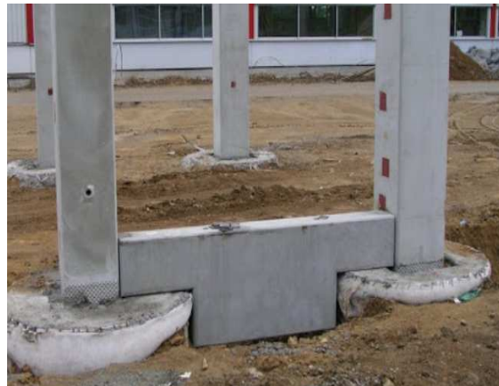
obr. /14/ Osazení ŽB prahu [12]
