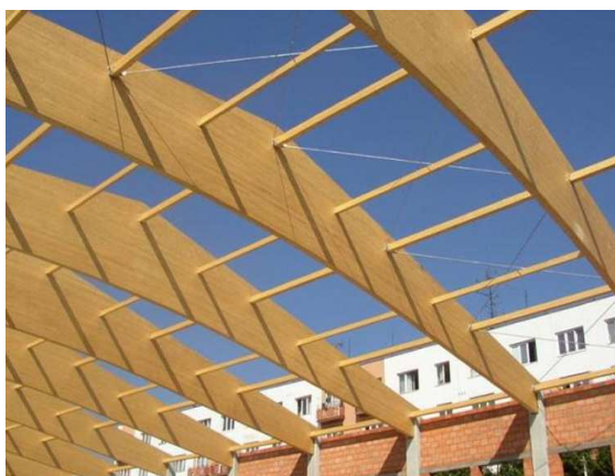
obr. /1/ Dřevěný lepený vazník [3]
