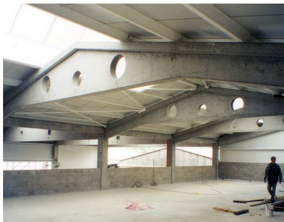
obr. /2/ Betonový sedlový T vazník [4]
