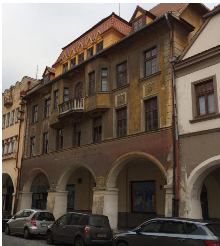
Prázdná budova v rekonstrukci, náměstí svobody 59, Hotel Hanslík pohled z náměstí Svobody Zdroj - Vlastní fotografie, 2020
