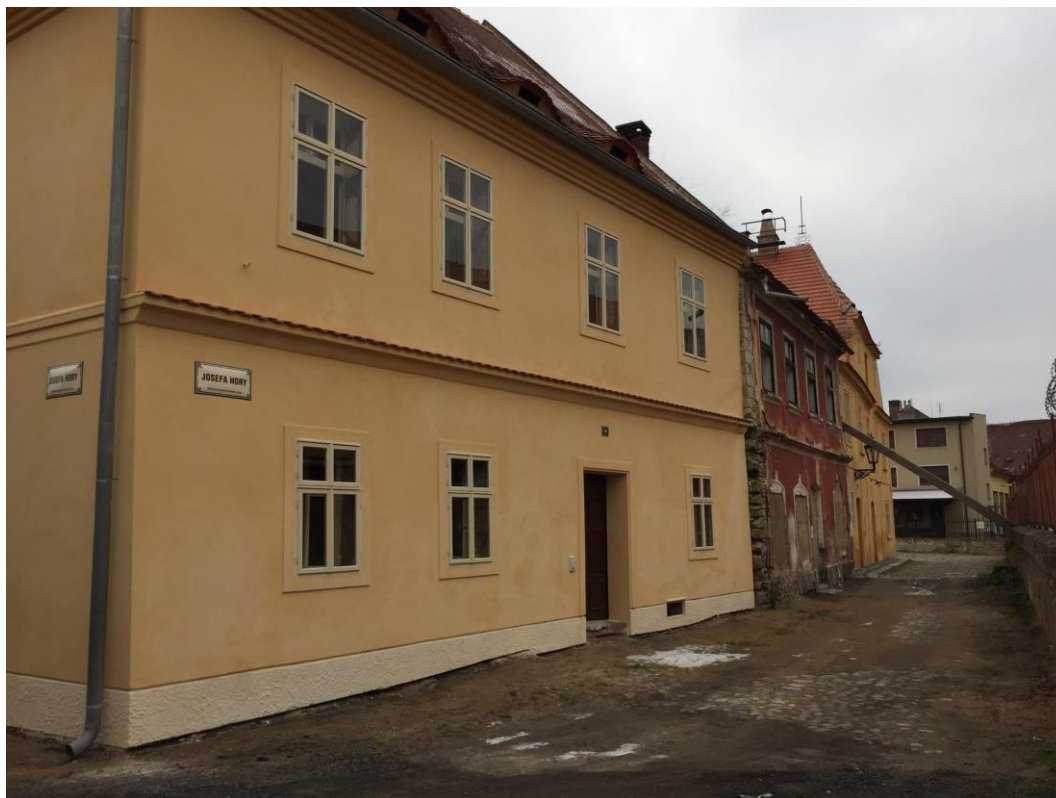
Budovy ve vlastnictví Žateckého pivovaru (zleva): budova v rekonstrukci J. Hory 84, prázdná budova J. Hory 639, rekonstruovaná budova J. Hory 85 - Muzeum pivovarnictví Žatecka Zdroj - Vlastní fotografie, 2020
