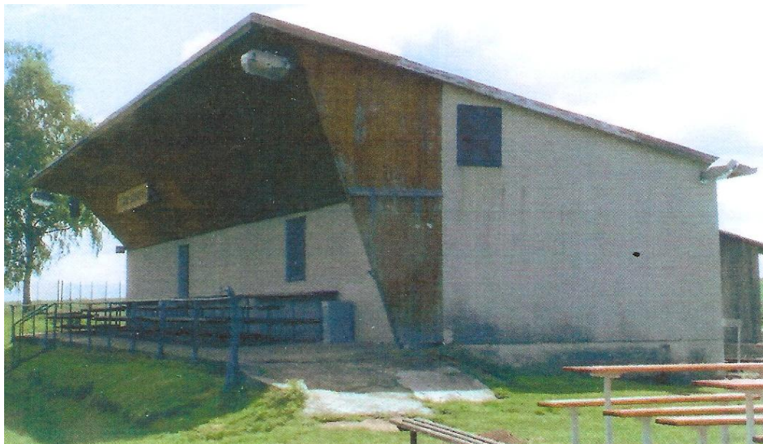
Obr. č. 17: Stávající fotbalové kabiny TJ Sokol Kasejovice
