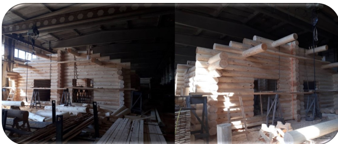
Obr. 13: První složení jednoho ze srubů v Bělorusku
