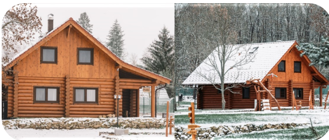
Obr. 15: Dokončené srubové domy
