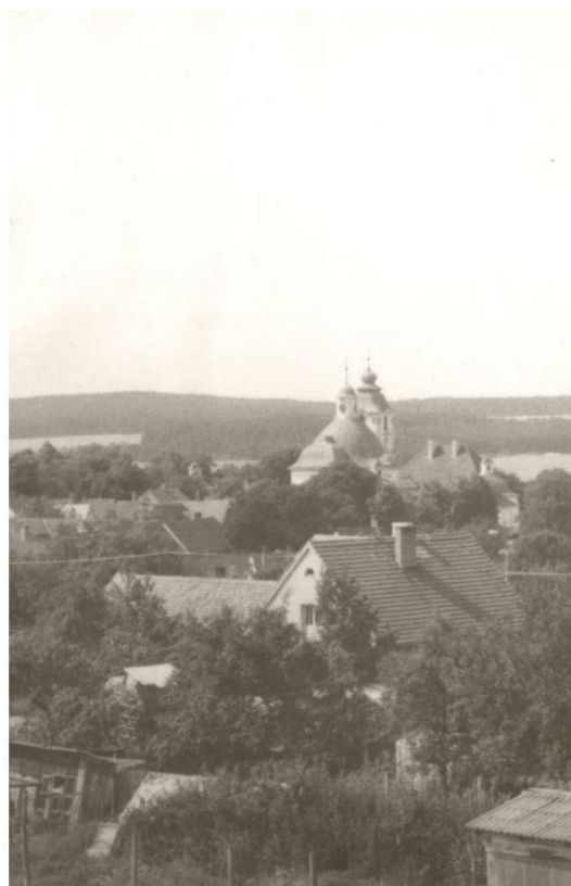
Obr. 2 Pohled na kostel (ze soukromého archivu JH).
