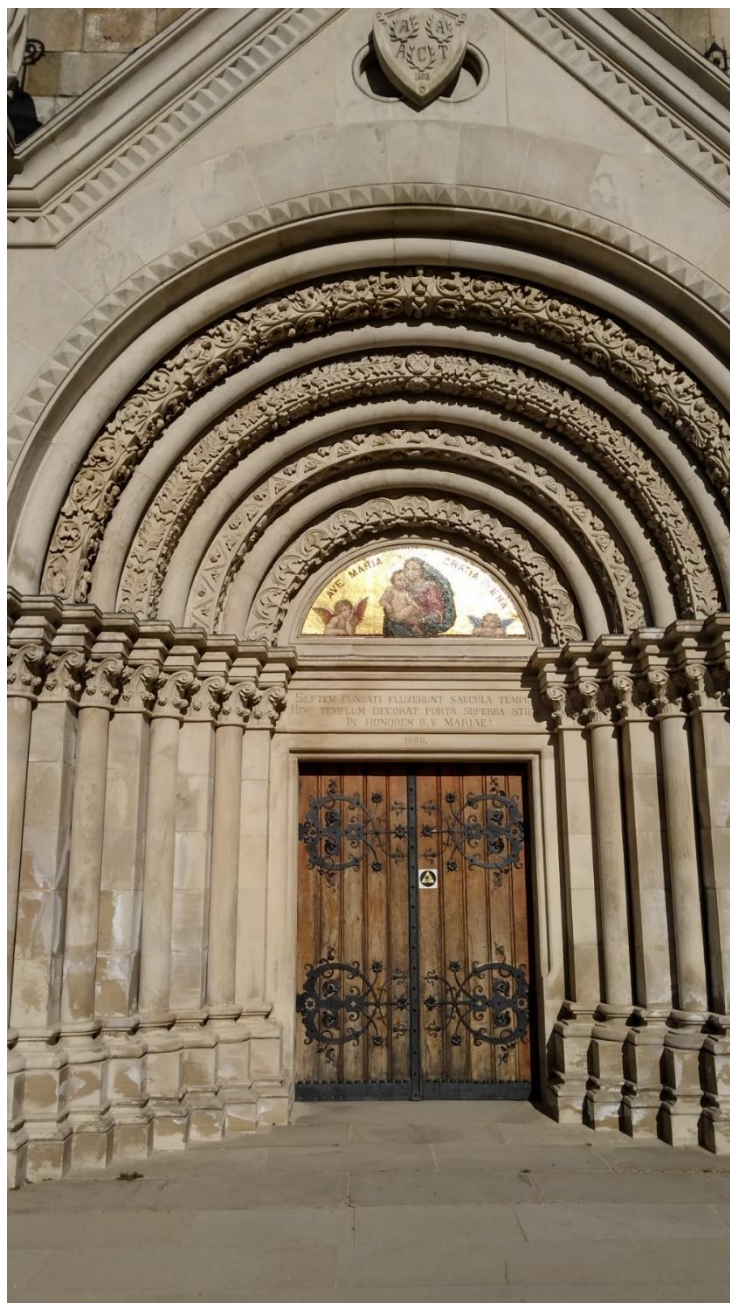
Obrázek č. 7: Portál hlavního vchodu. Fotografie autorky. Dne 16. 04. 2020.
