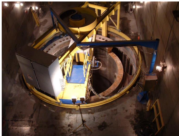
Obr. 87 – dělení tlakové nádoby in situ pomocí vodního paprsku [29]
