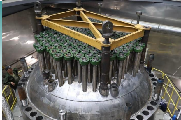
Obr. 80 – nová reaktorová hlava reaktoru v JE Leningrad [17]
