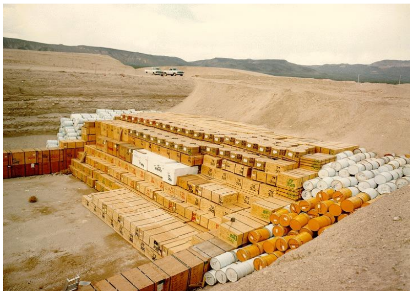
Obr. 73 – skladiště nízko radioaktivního odpadu před zasypáním [11]
