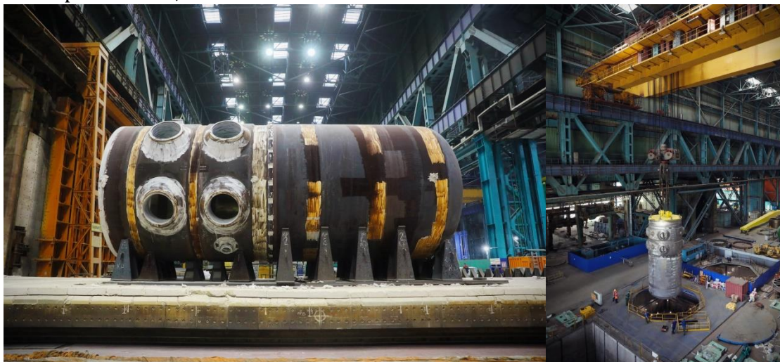
Obr. 84 – hrubý svařenec reaktorové nádoby typu VVER JE Akkuyu (TU) [23] Obr. 85 – nádoba při instalaci [24]
