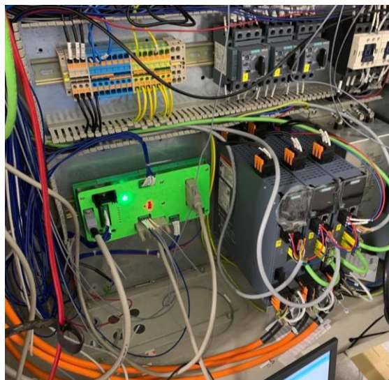
Obrázek 7 Zástavba Arduina do rozvaděče [9]
