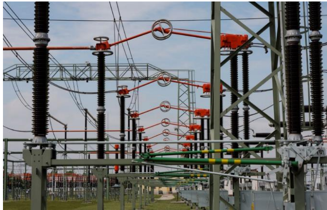
Obrázek 2.16 Venkovní vertikální odpojovač [22]
