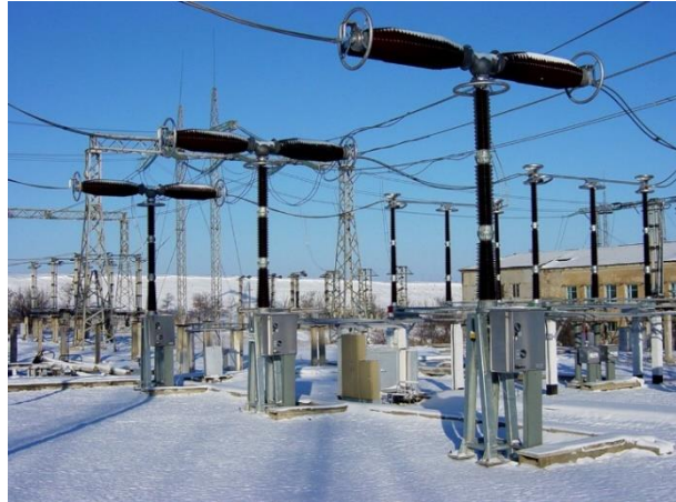
Obrázek 2.14 Výkonový vypínač do 400 kV [21]
