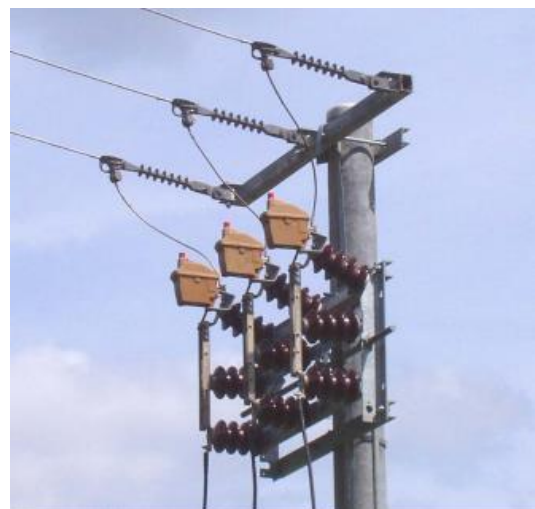
Obrázek 2.15 Venkovní úsekový odpínač [28]
