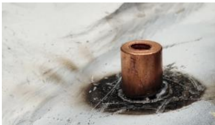
Obrázek 46: Nežádoucí oxidace u čepu přivařeného na bílou podkladovou barvu
