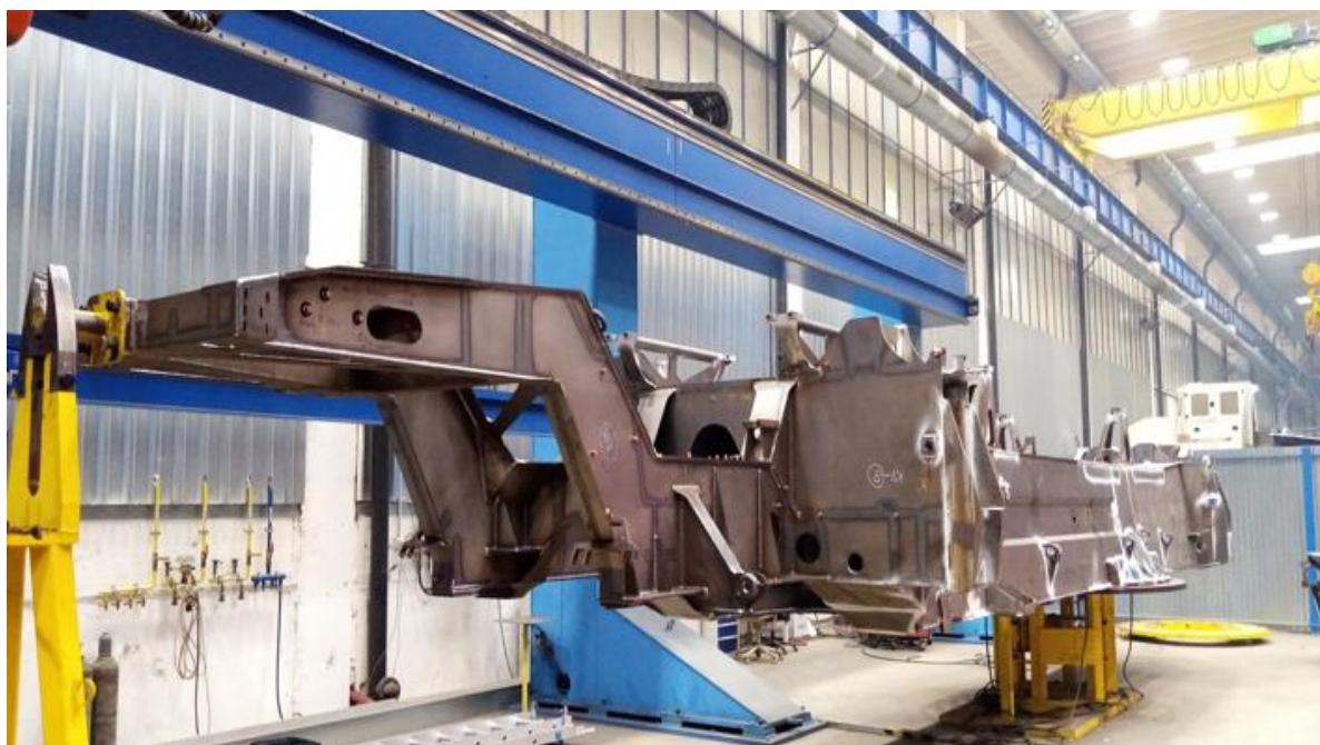
Obrázek 57: Pracoviště robota na přivařování čepů
