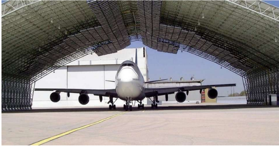
Obr. 15 Infračervené odmrazování (převzato z [64])
