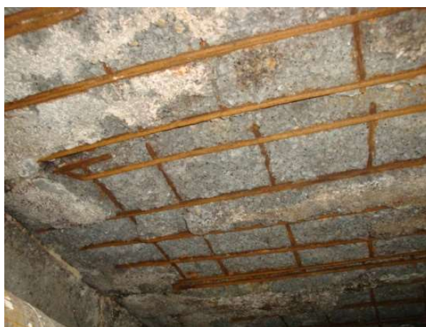
Obr.2.1.3 - Schéma nebezpečí karbonatice a ukázka odpadlé celé krycí vrstvy výztuže [21]
