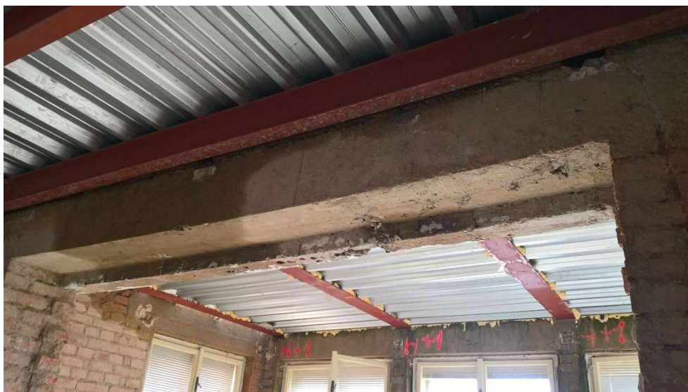
Obr.5.2.9.f – Sonda č.2 – Aplikace fenolftalienu- pohled z boku
