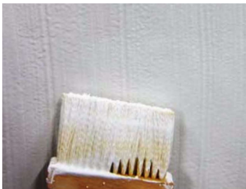
Obr. 7.4.1.c - Zapracování první vrstvy MasterSeal 6100 FX do podkladu pomocí štětce [29]
