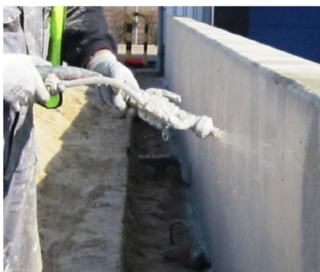
Obr. 7.4.1.d - Aplikace MasterSeal 6100 FX nástřikem [29]
