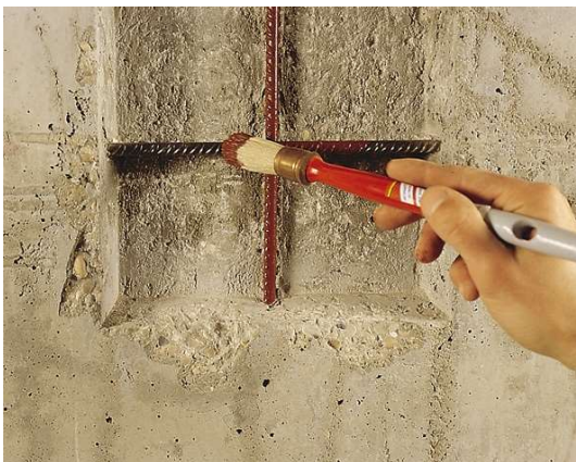
Obr.2.7.2 – Ochrana ocelové výztuže
