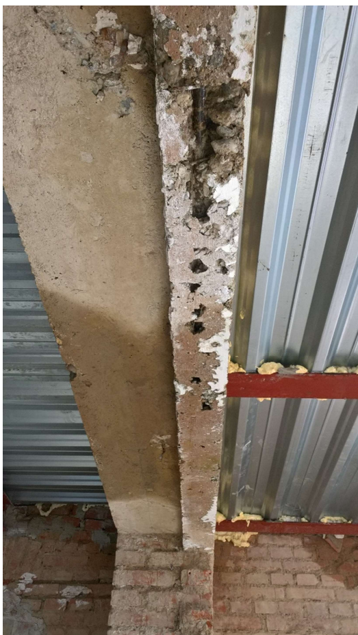
Obr.5.2.9.g a 5.2.9.h – Sonda č.2 – Aplikace fenolftalienu- pohled zespodu
