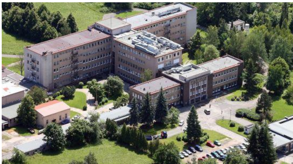
Obr. 1 - Hlavní budova Rokycanské nemocnice a.s. - současnost [4]
