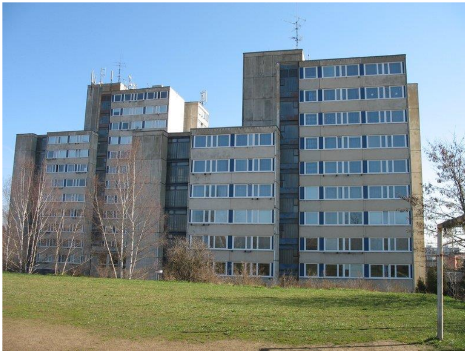
Obr. 13 – Domov mládeže při SPŠD Karlovarská 99, Plzeň [37]
