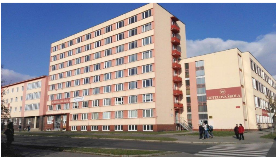
Obr. 10 – Domov mládeže při Hotelové škole - pohled na budovu [35]
