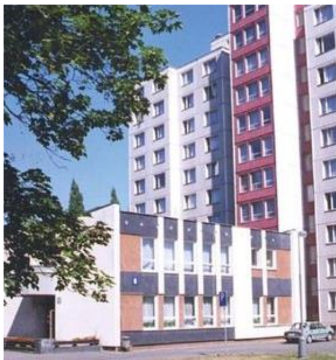
Obr. 12 – Domov mládeže při SOUE Plzeň - pohled na vstup do budovy [36]
