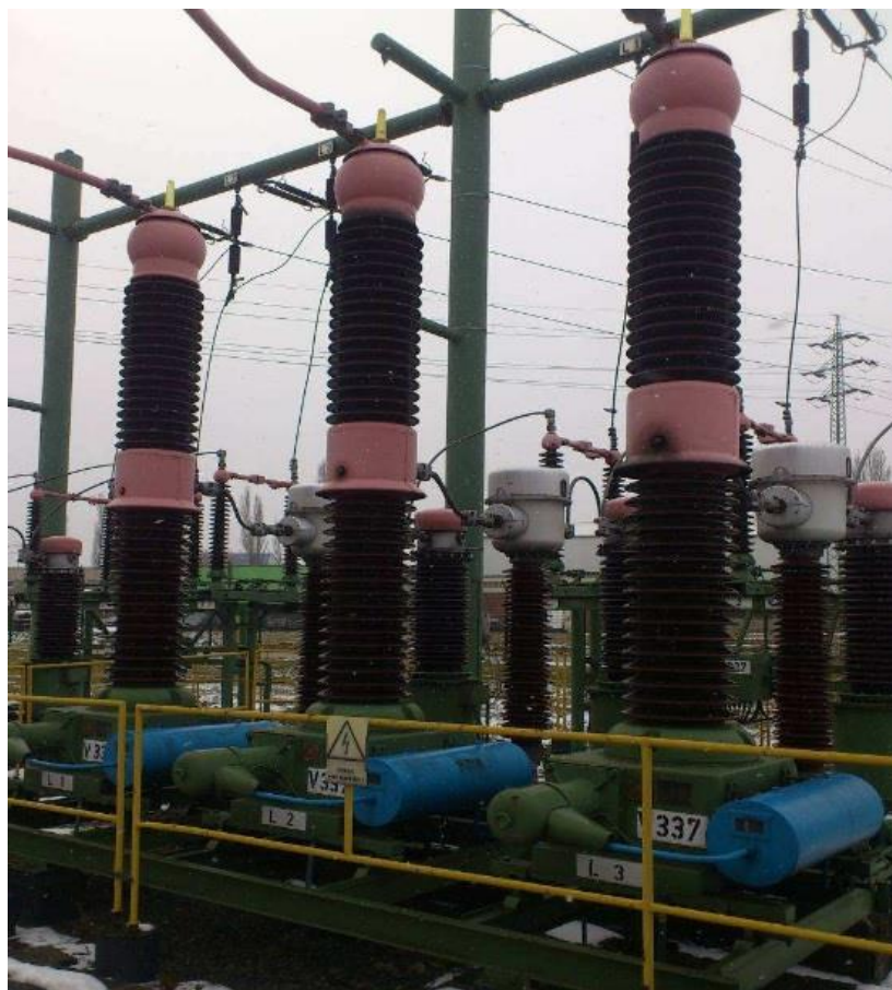
Obr. 5. Máloolejové vypínače VVN (převzato z [12])
