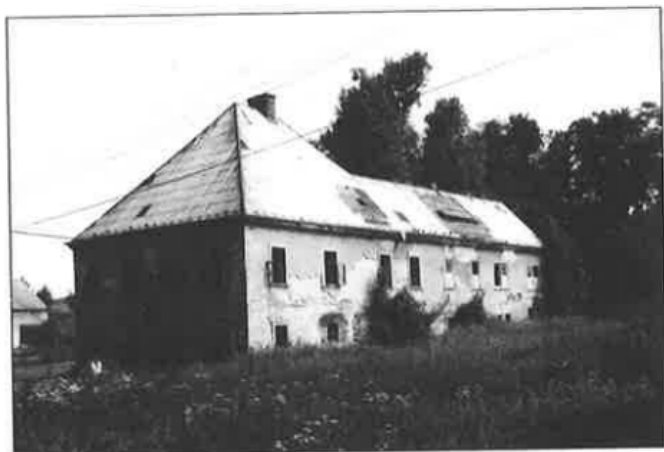
Krásný Les, jihovýchodní zámecké průčelí. Fotografie z června 2002 dokládá postupující devastaci zámku. Střešní krytina na mnoha místech chybí a zatékající voda ničí strop patra. Foto autor.
