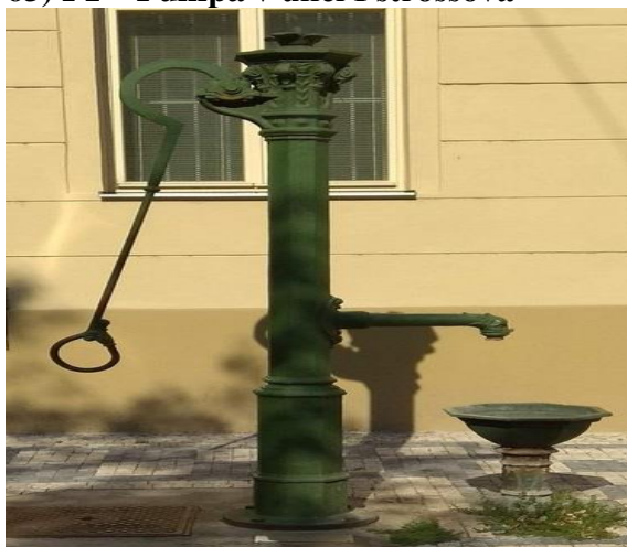
63) P1 – Pumpa v ulici Pštrossova
