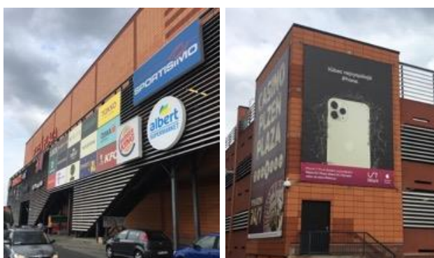
Obrázek 41: Pohled na budovu OC Plzeň Plaza
