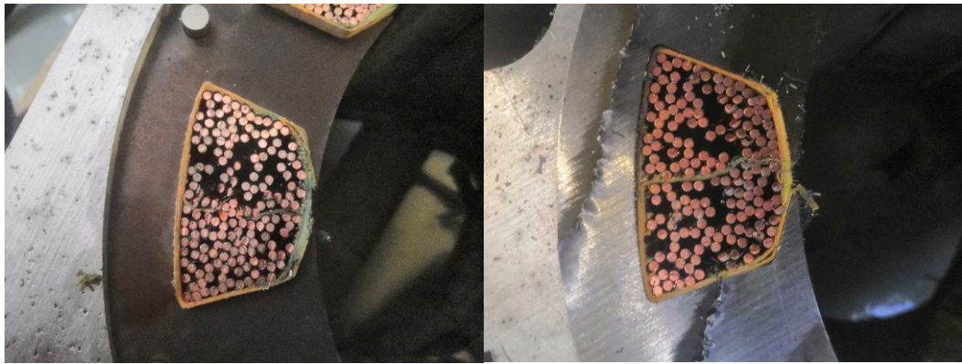
Obr. 13 Příklad špatně impregnovaného vinutí statoru
