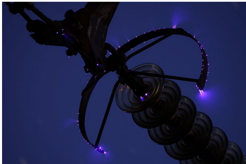
Obr. 1.2 Koronový výboj na izolátoru 500 kV nadzemního vedení, převzato z [22]
