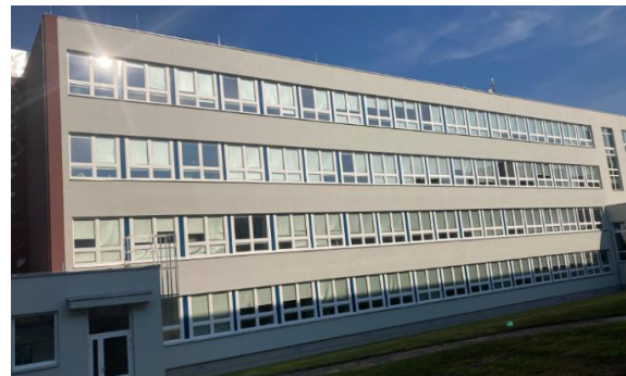
Obr. 2.29 Pohled na budovu základní školy
