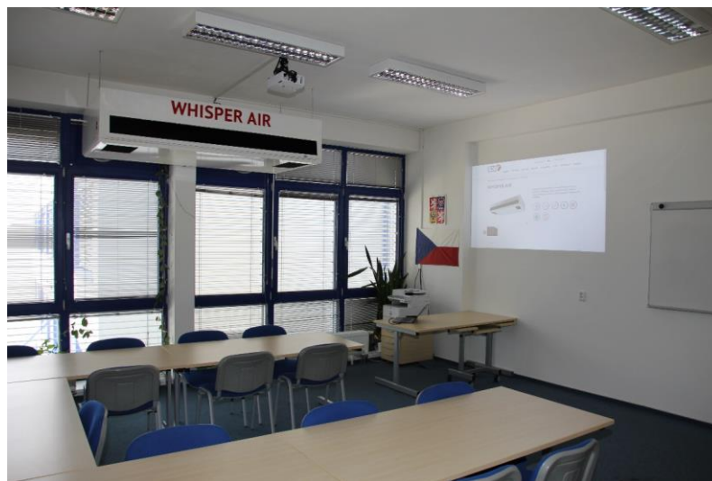
Obr. 2.20 Instalace rekuperační jednotky v zasedací místnosti
