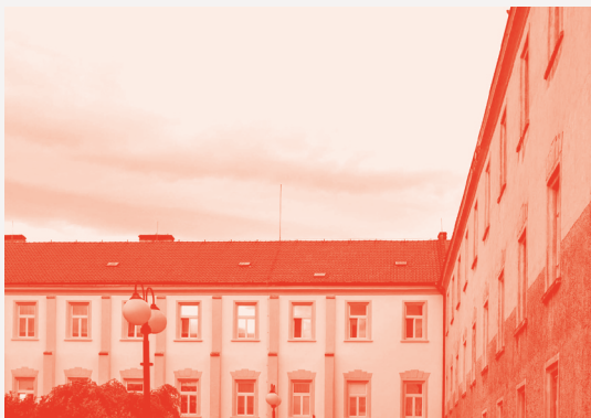
• PAVILON S, BÝVALÝ PIARISTICKÝ KLÁŠTER
