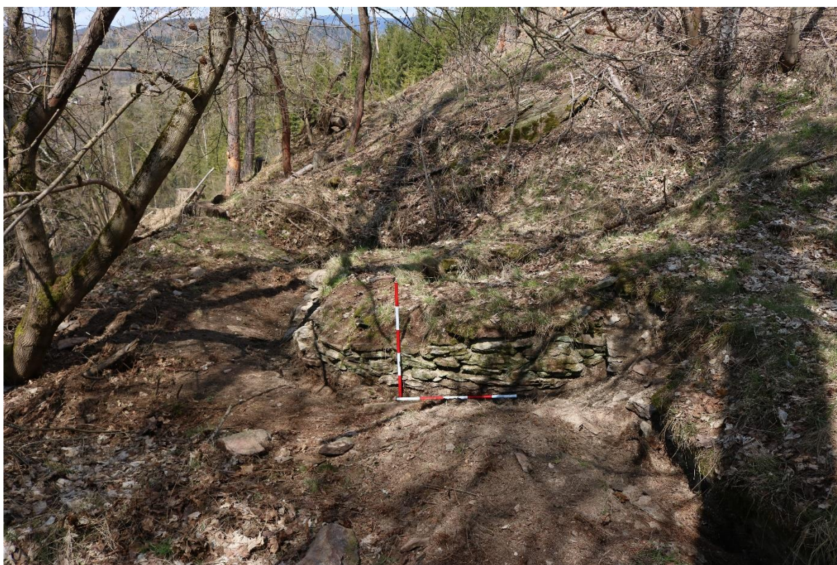
Obr. 10: Pozůstatek okrouhlé stavby – bašty. Foto K. Hanáková.
