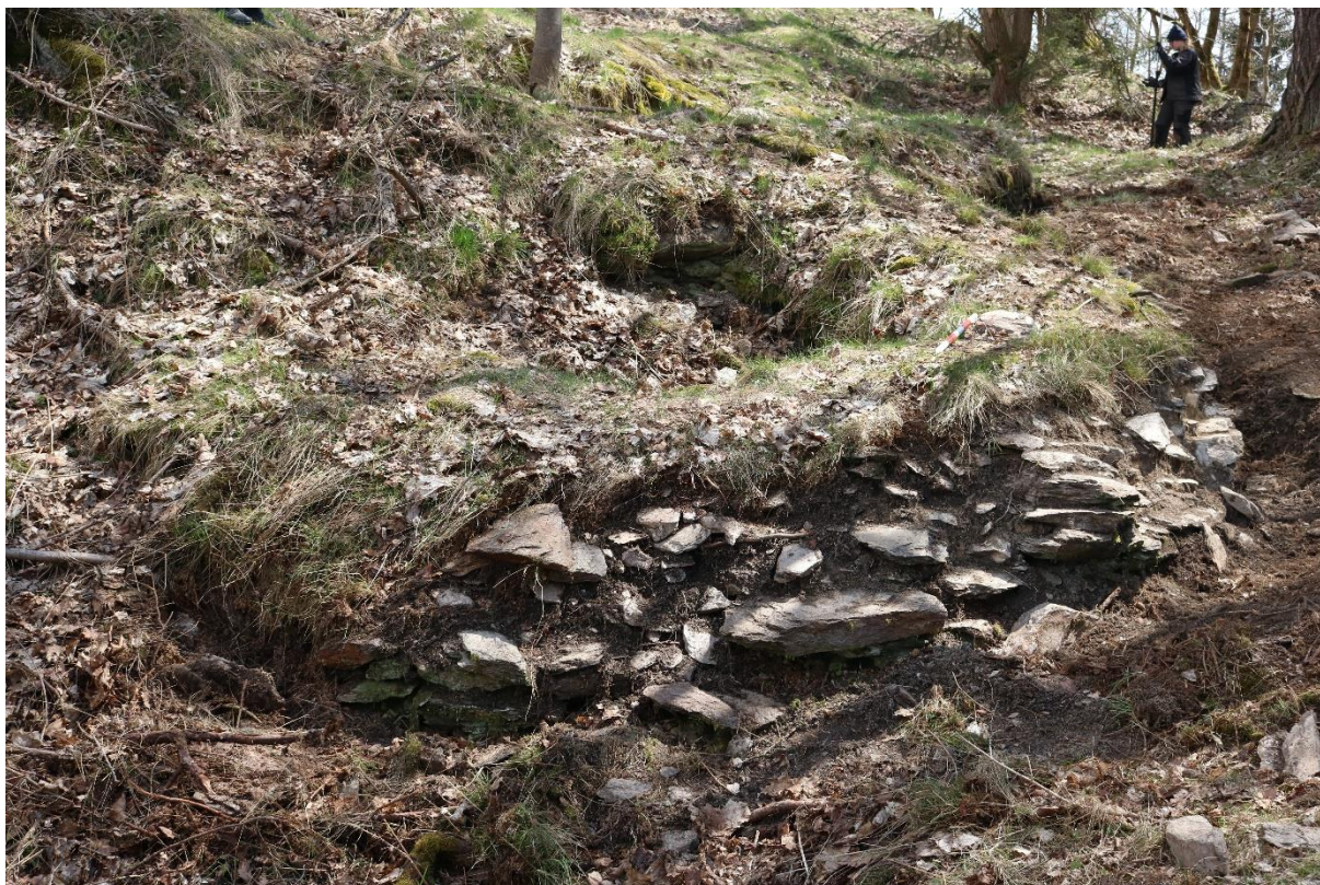
Obr. 11: Pozůstatek okrouhlé stavby – bašty. Foto K. Hanáková.
