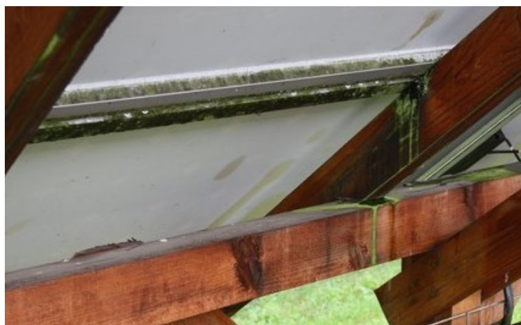
Obr. 8.8: Lepší řešení umístění spoje panelů
