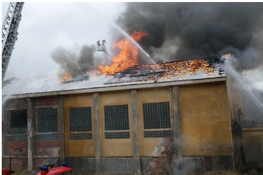
Obr. 6.1: Ukázkový požár střechy budovy s fotovoltaickými panely
