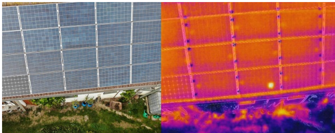
Obr. 7.2: Revize fotovoltaického pole pomocí infračervené kamery [71]
