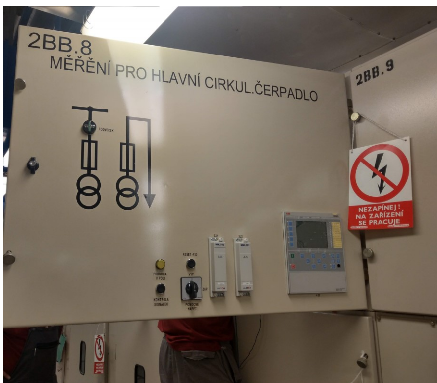
Obr. 3.12: Osazení nových dveří přístrojové části 2BB.8 [zdroj: archiv autora]
