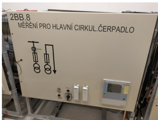
Obr. 3.9: Dveře přístrojové části 2BB.8 před montáží do rozvaděče 2BB [zdroj: archiv autora]
