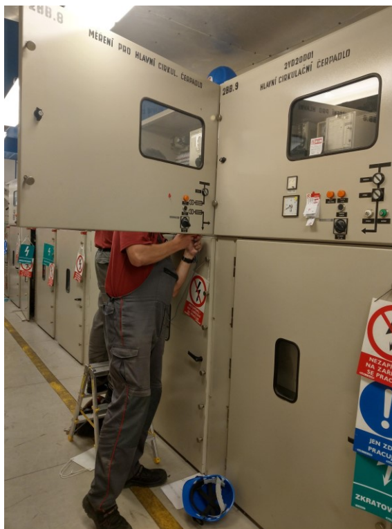
Obr. 3.10: Demontáž původních dveří přístrojové části 2BB.8 a 2BB.9 [zdroj: archiv autora]
