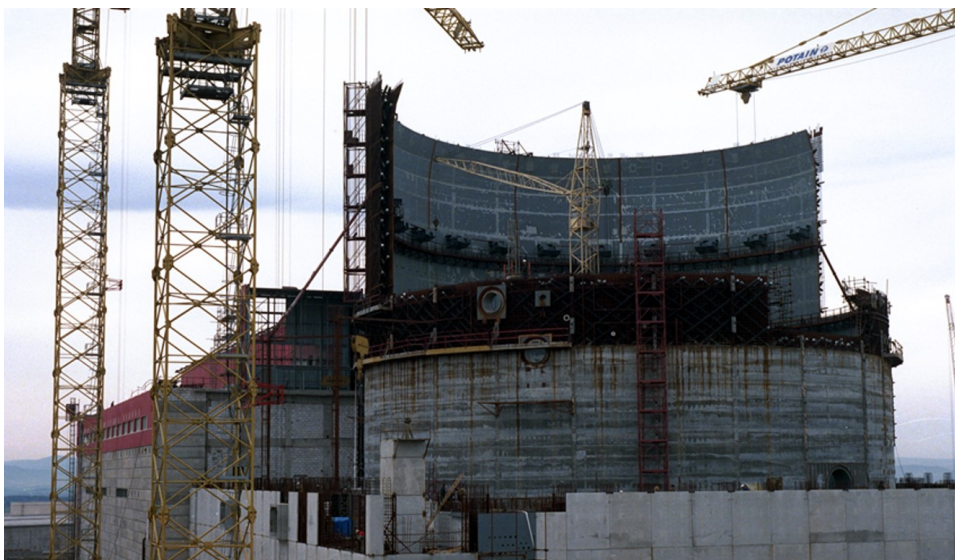
Obr. 1.1: Budova reaktoru - výstavba kontejnmentu [24]
