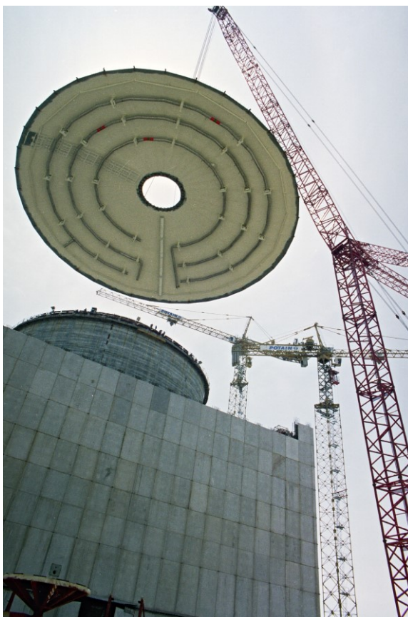
Obr. 1.2: Budova reaktoru - osazení kopule kontejnmentu [24]
