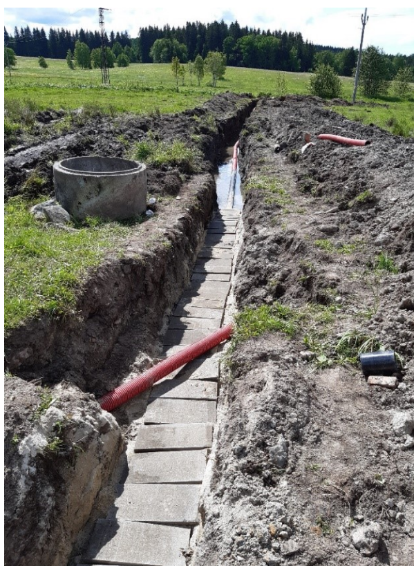
Obr. 23: Ukázka pokládky VN kabelu do pískového lože s překrytím betonovými deskami [Zdroj: archiv autora]
