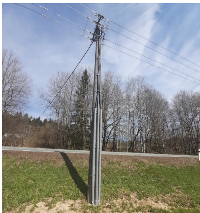
Obr. 27: Vyvedení kabelových vývodů na sloup [Zdroj: archiv autora]
