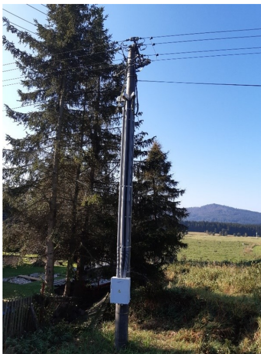
Obr. 26: Podpěrný bod na pozici 02 po rekonstrukci (zde byl dříve osazen regulátor) [Zdroj: archiv autora]
